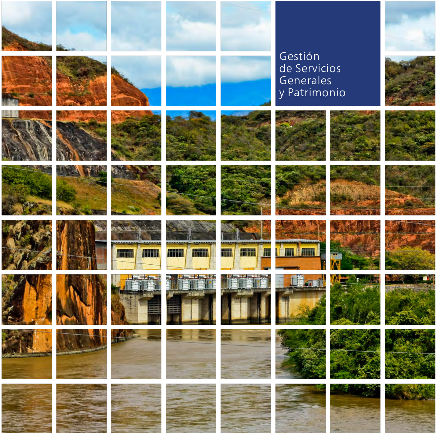
Central Hidroeléctrica Betania, Huila
