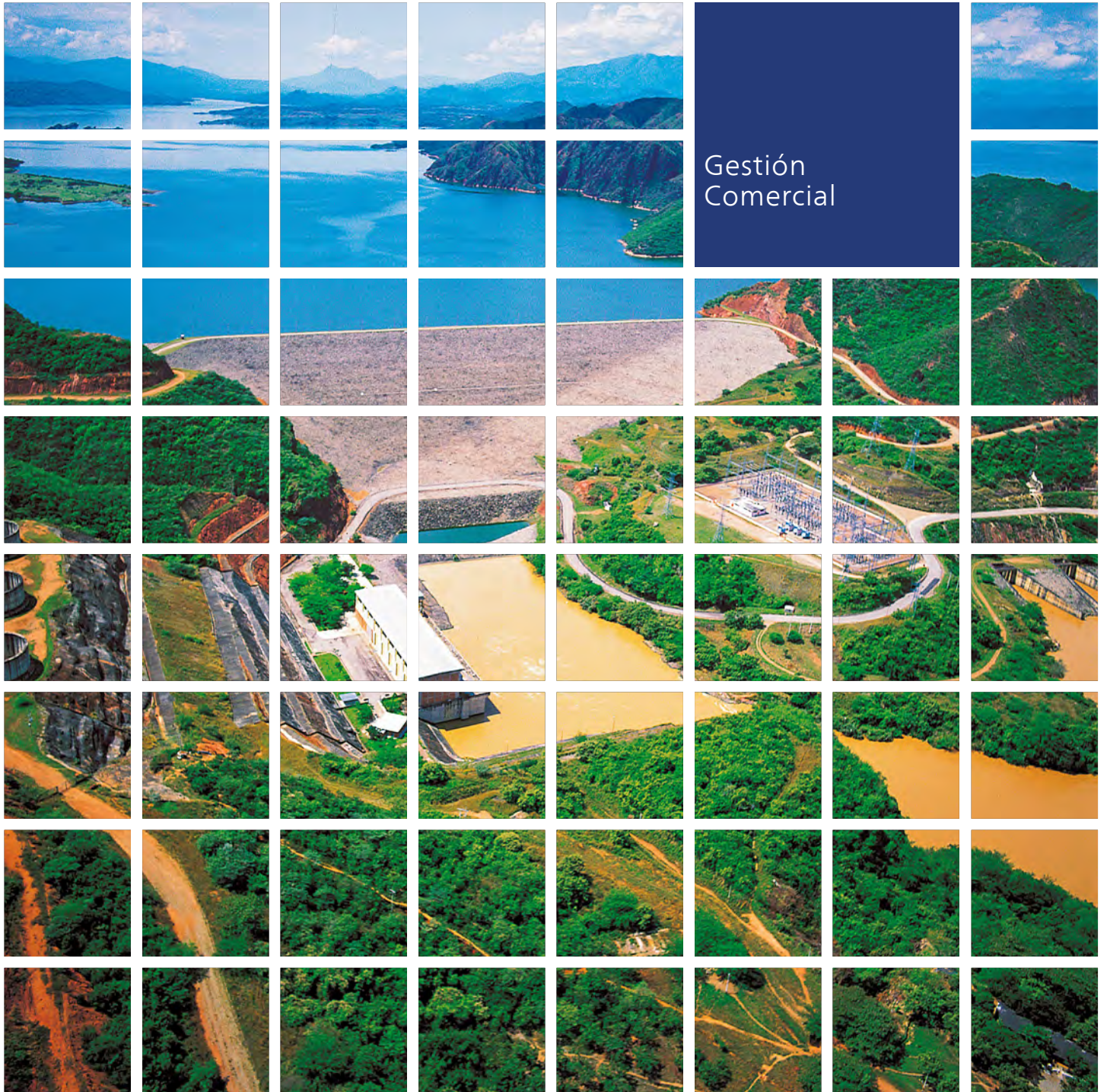
Central Hidroeléctrica Betania, Huila
