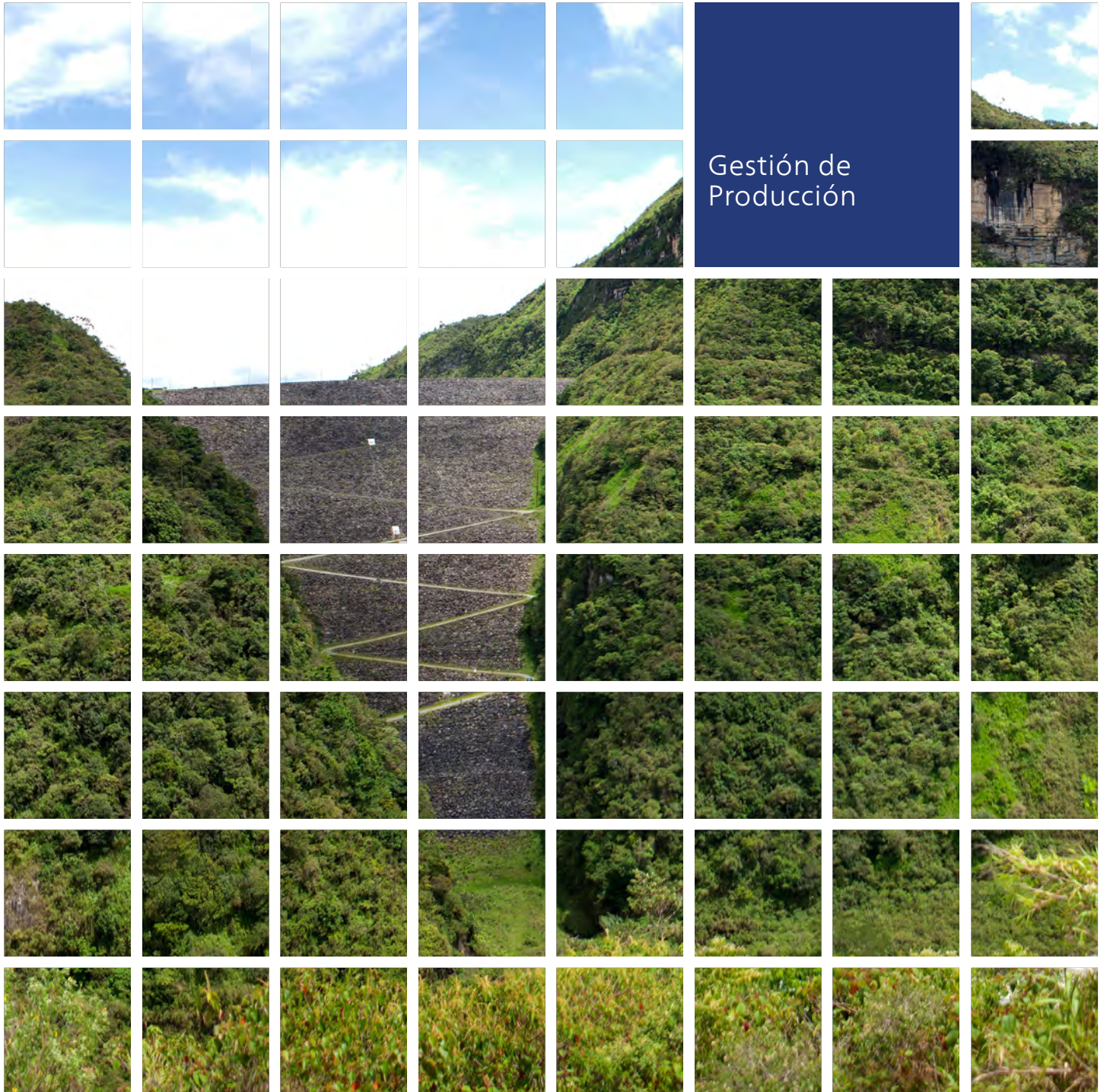
Central Hidroeléctrica El Guavio, Cundinamarca.
