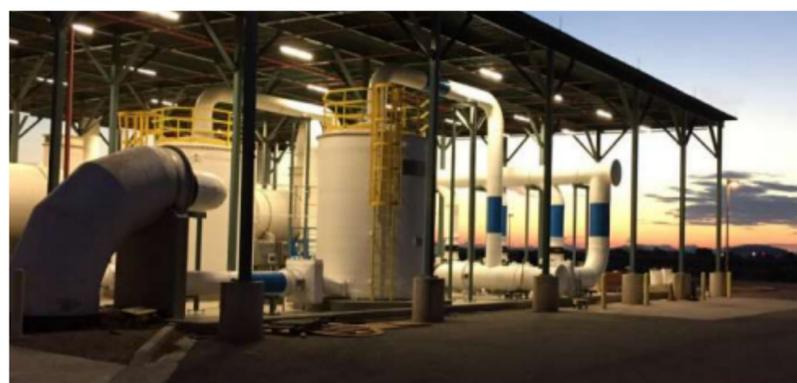
Iniciamos la construcción de un ecofiltro para la **Central Hidroeléctrica El Paraíso**, con el fin de eliminar el sulfuro de **hidrógeno (H<sub>2</sub>S)** de las aguas del **río Bogotá** que utilizamos en el proceso de generación de energía eléctrica. Esta solución innovadora hará parte del sistema de **biofiltración** que actualmente opera de manera eficiente en la Central.
