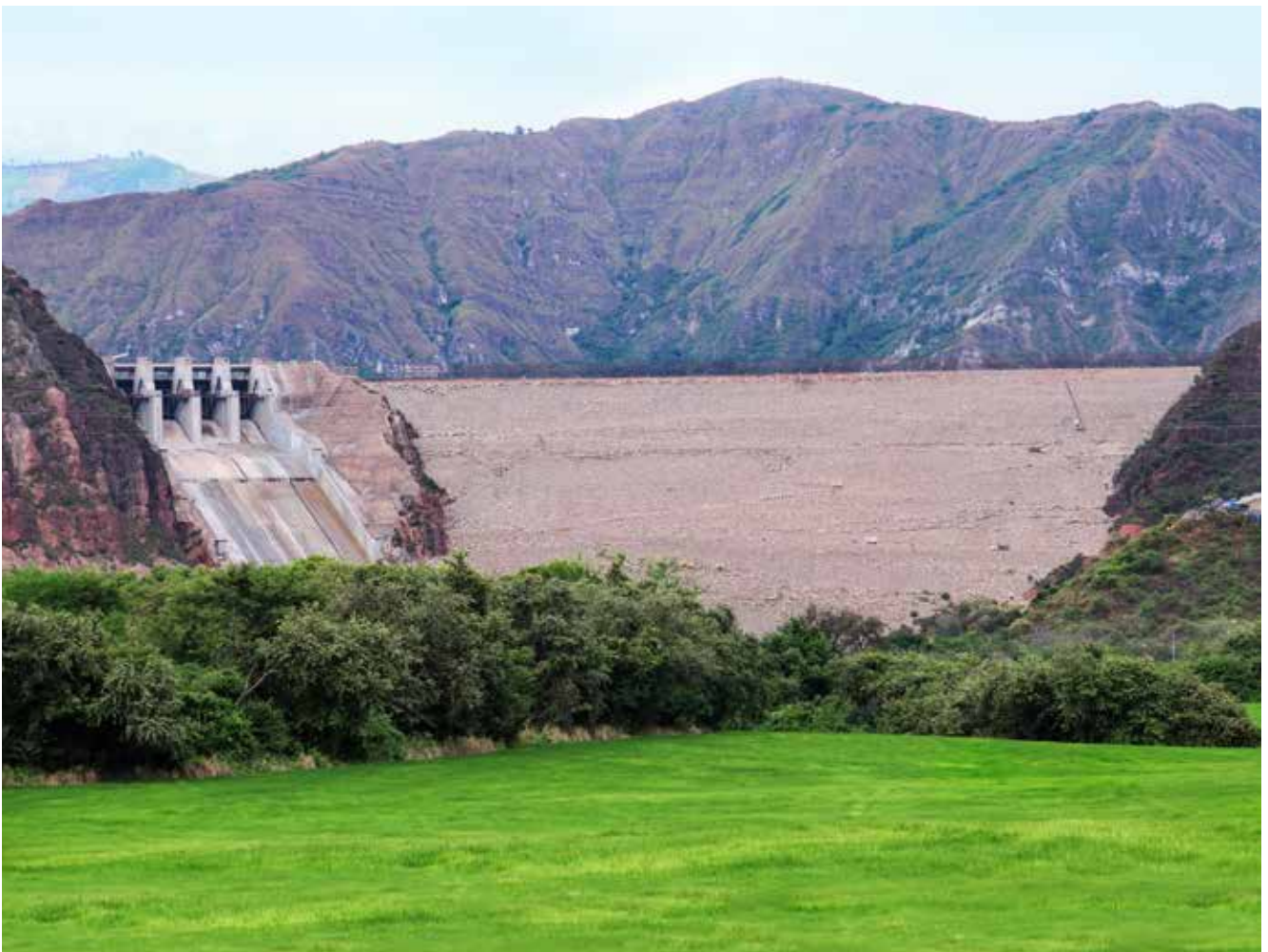
Central Hidroeléctrica El Quimbo
