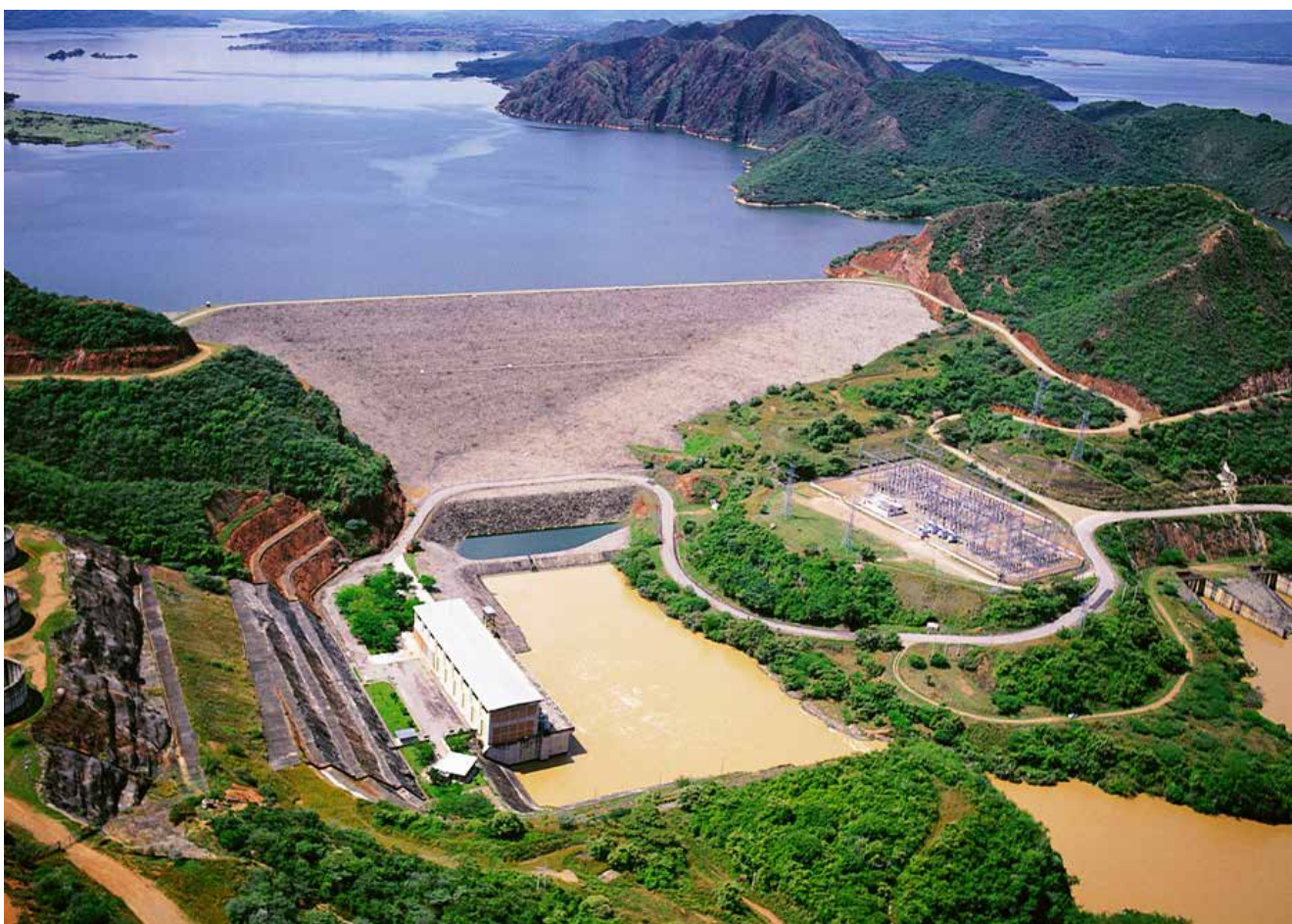
Central Hidroeléctrica Betania
