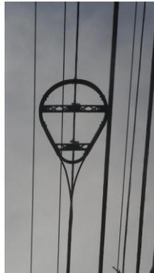
Figure 3 – Raquetas de almacenamiento de cable de fibra entre postes.
