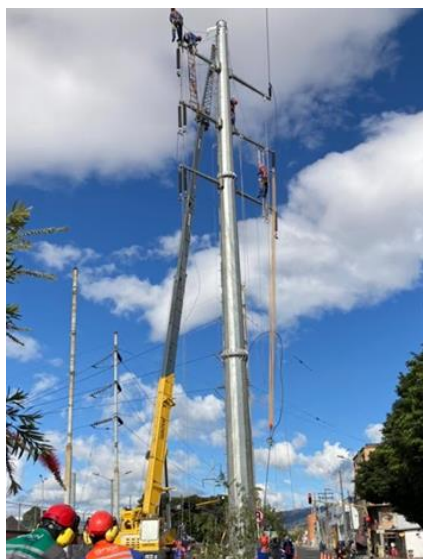
Figura 3-15 Instalación de postes metálicos por secciones que se vinculan con empates metálicos
