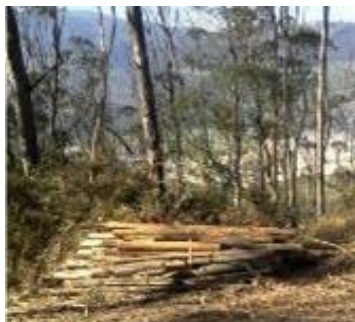
Tala y remoción cobertura vegetal
