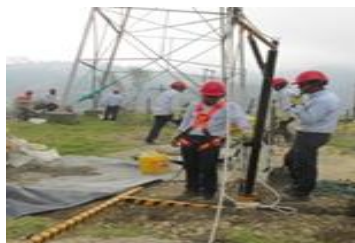
Cimentación relleno y compactación de estructuras
