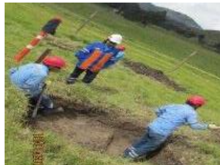
Excavación para cimentación
