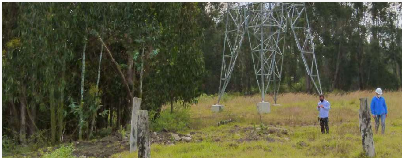
2. Línea de transmisión en doble circuito a 115 kV de 1,8 km que se conectará a línea Nueva Esperanza – Techo en los predios Tequendama.
