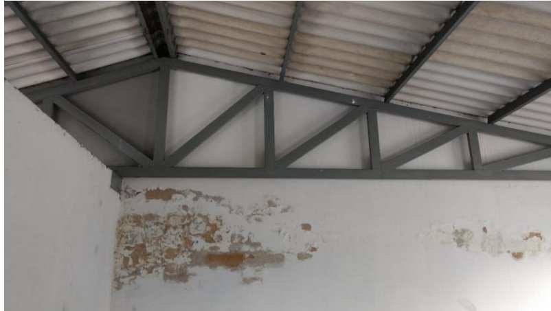
FOTOGRAFÍA 2.13. DETALLE DEL SISTEMA ESTRUCTURAL DE CUBIERTA.
