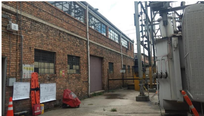
FOTOGRAFÍA 2.3. VISTA EXTERIOR DE LOS MUROS DE CARGA DE LA EDIFICACIÓN
