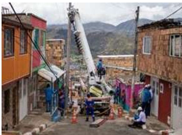
Fabricación e instalación de postes con materiales reciclados- Localidad de Úsme.
