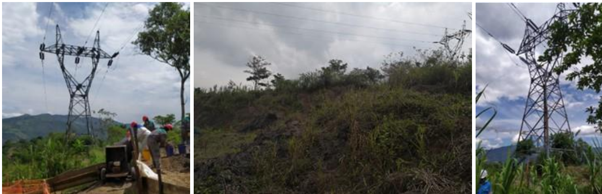
Fotografías de los trabajos adelantados en la línea Faca-Villeta
