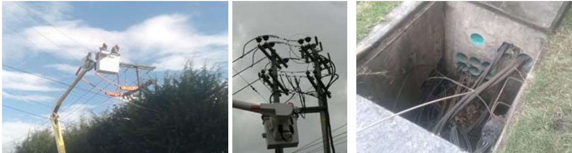
Fotografías de los trabajos realizados para habilitación de nuevo circuito auxiliar
