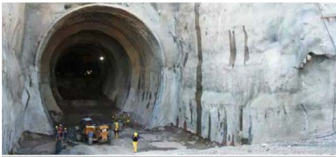
Entrada al Túnel de Desviación
