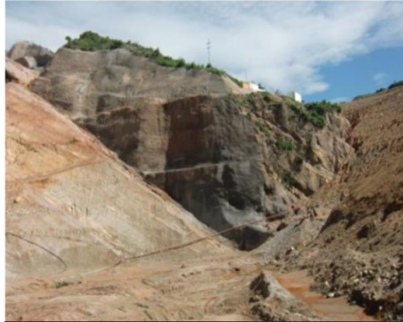
Excavación plinto
