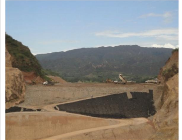
Rellenos etapa 1 presa
