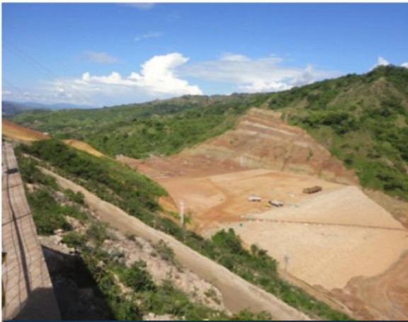
Excavaciones del pozo de compuertas No. 1
