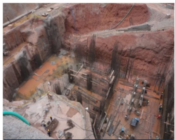
Hormigones en la zona de unidades casa de máquinas
