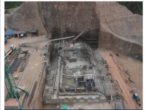
Trabajos en la estructura de control del vertedero
