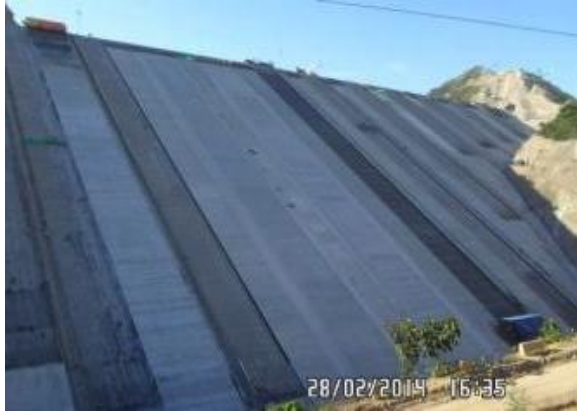
Presa – Espaldón Aguas Arriba
