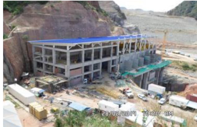
Casa de Máquinas – Cubierta Edificio de Control
