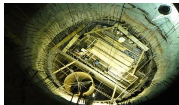
Pozo de Compuertas – Revestimiento
