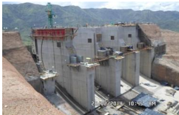
Vertedero – Estructura de Control
