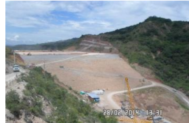
Dique Auxiliar – Espaldón Aguas arriba
