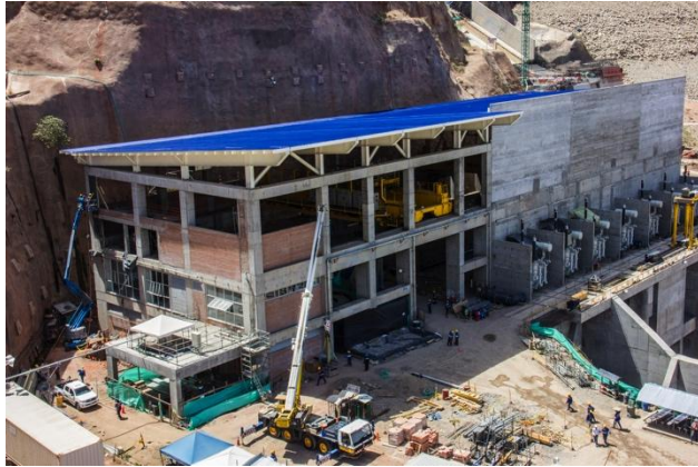
Panorámica Casa de Maquinas
