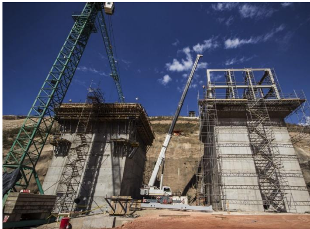
Bocatoma: Túnel de carga 1 y 2
