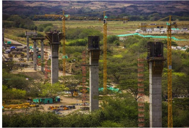
Dovela cero eje 8 Puente Balseadero.
