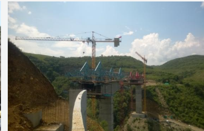
Tramo IV: Vigas - Puente La Cañada
