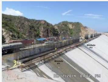
Presas – Acero de refuerzo Muro Parapeto
