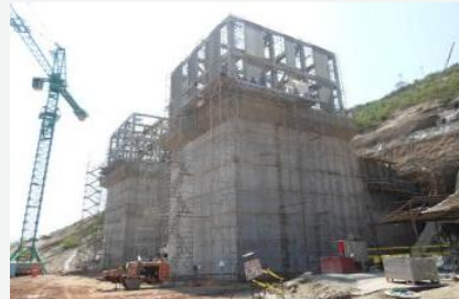
Bocatomas: Montaje estructura de rejilla
