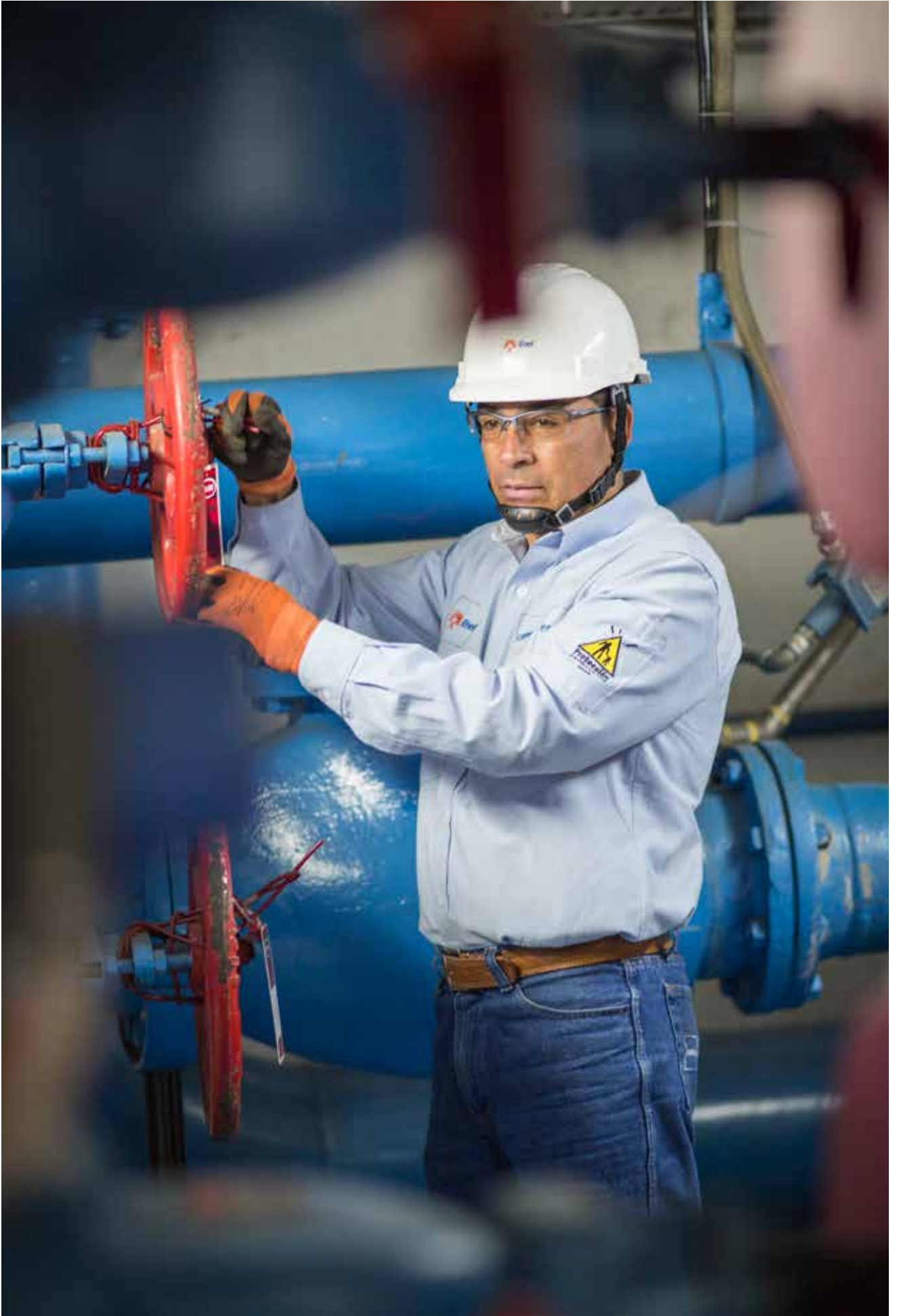
Central Hidroeléctrica Charquito
