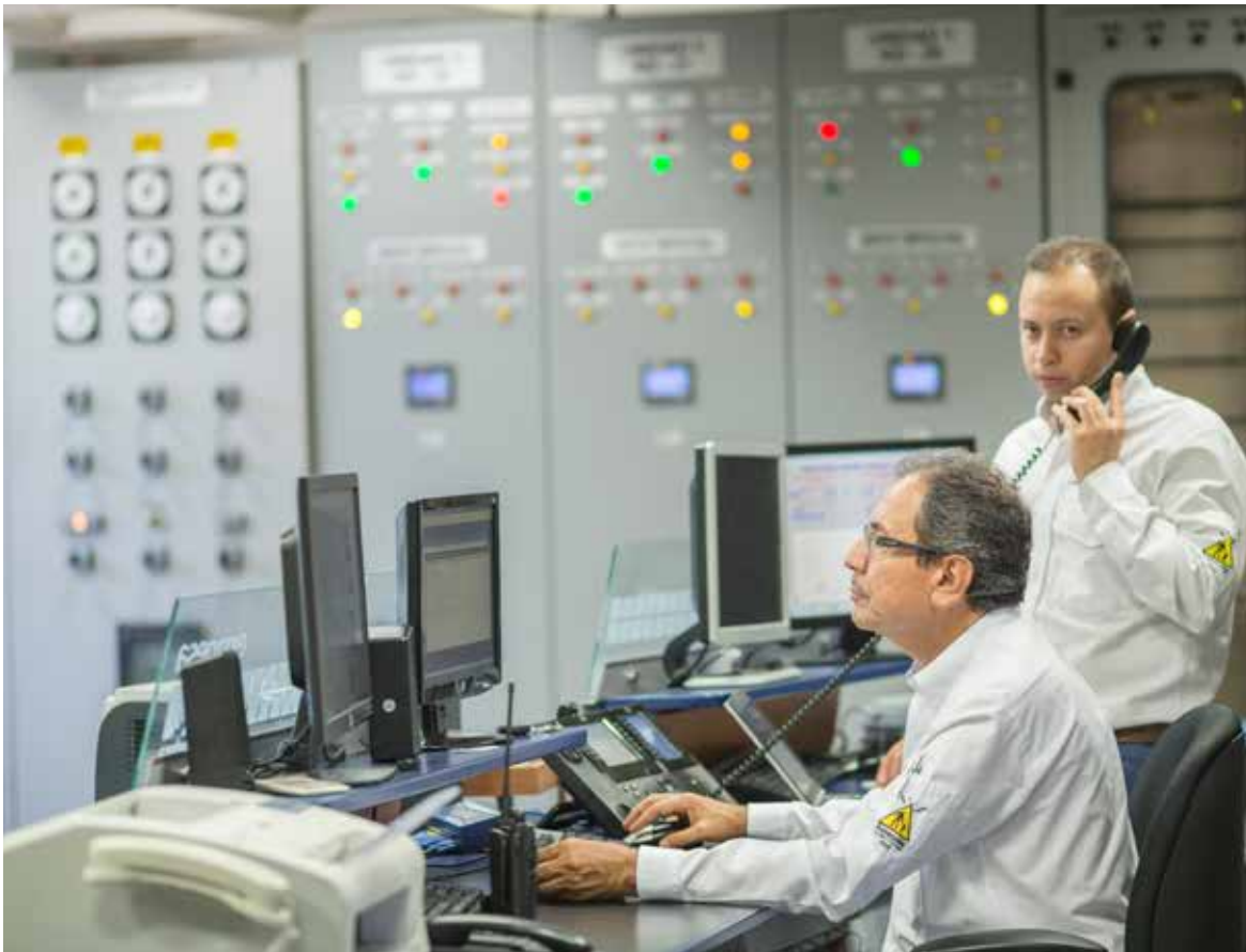
Operación Central Hidroeléctrica La Guaca
