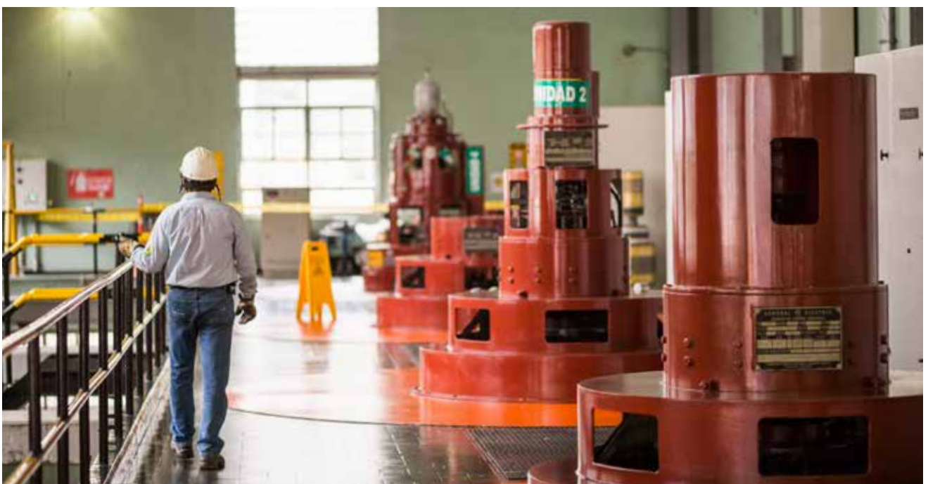
Central Hidroeléctrica Limonar
