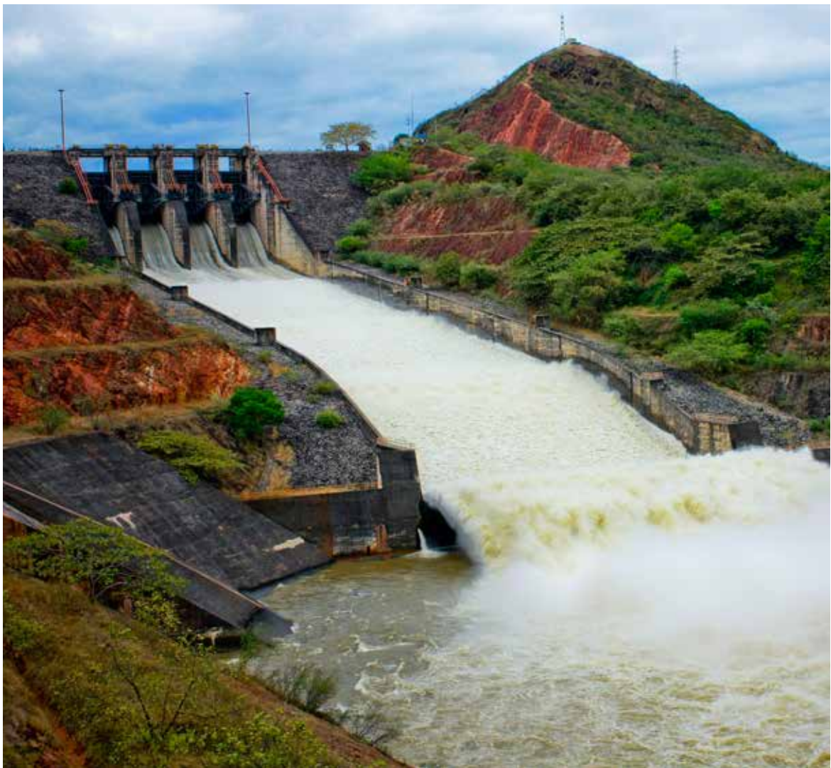
Central Hidroeléctrica Betania
