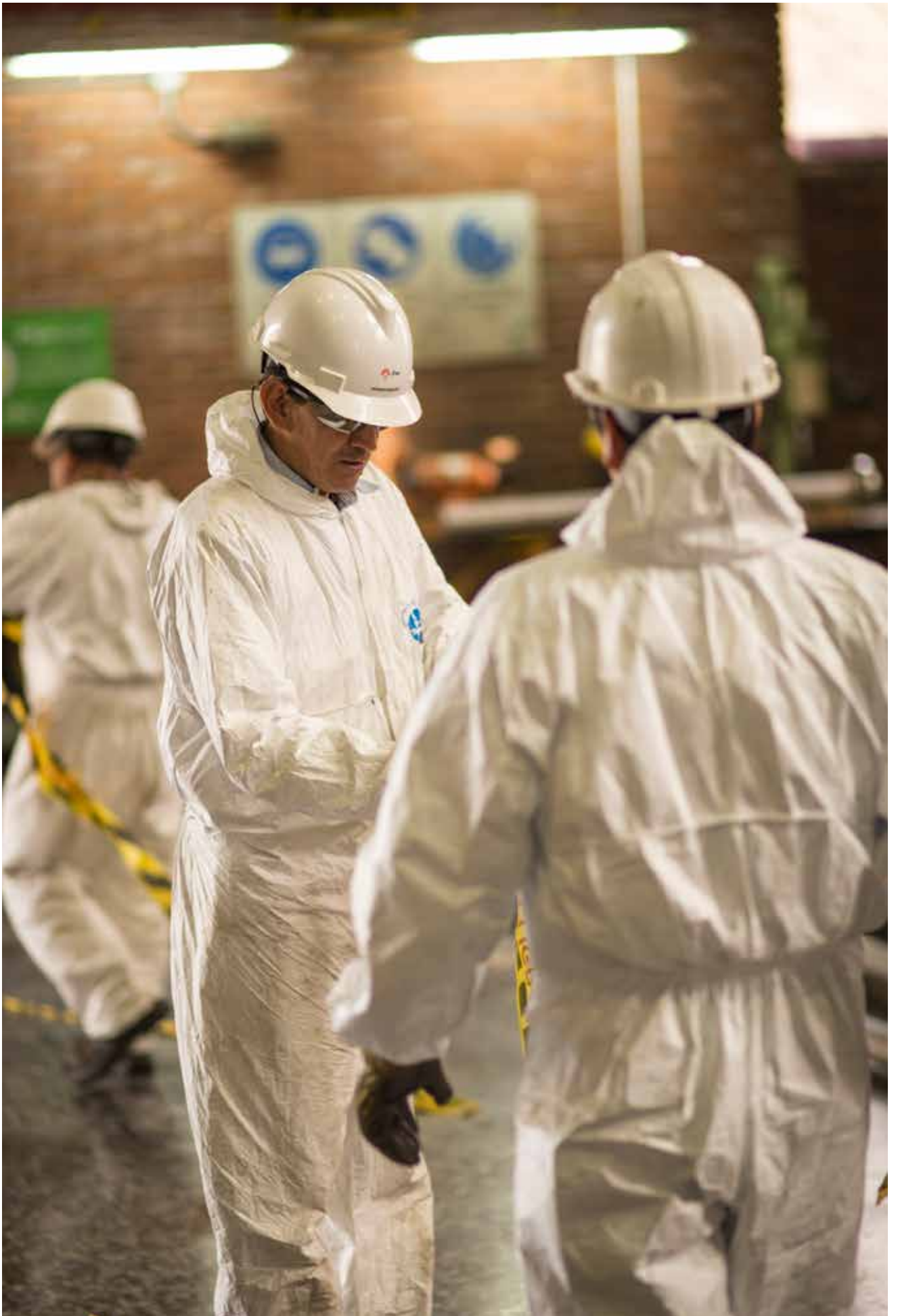
Mantenimiento Estación de Bombeo Muña
