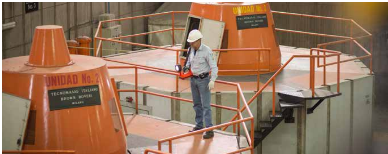
Estación de Bombeo Muña
