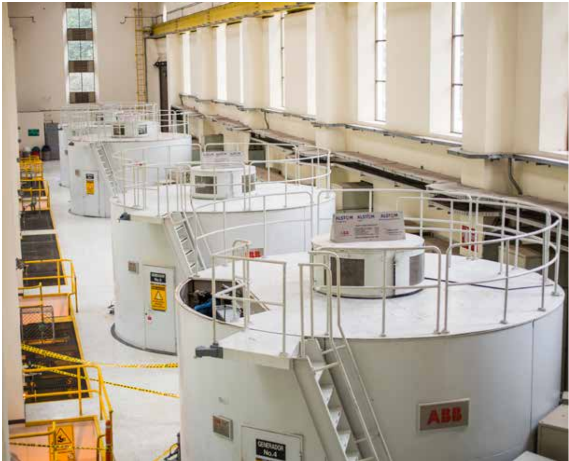
Central Hidroeléctrica Tequendama
