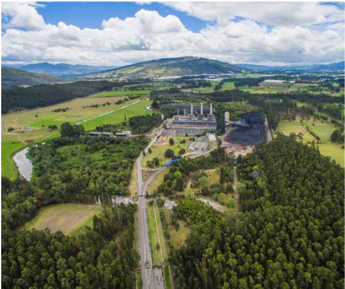
Central Térmica Termozipa
