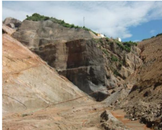
Excavación plinto
