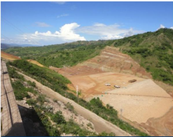
Excavaciones del pozo de compuertas No. 1
