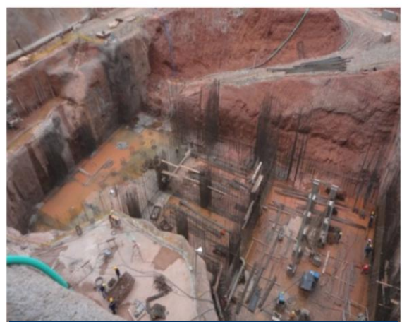
Hormigones en la zona de unidades casa de máquinas
