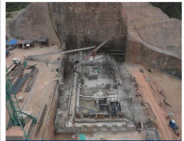
Trabajos en la estructura de control del vertedero
