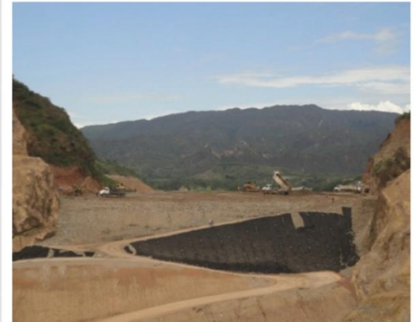
Rellenos etapa 1 presa
