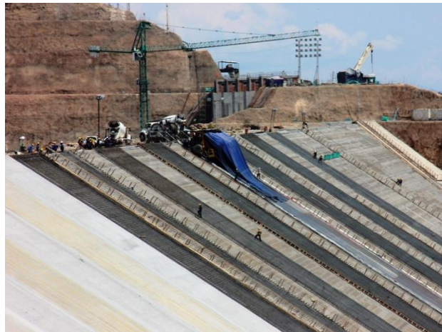
Presas – Panorámica de los rellenos etapa IV espaldón aguas arriba
