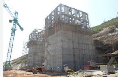
Bocatomas: Montaje estructura de rejilla
