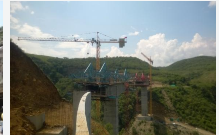
Tramo IV: Vigas - Puente La Cañada
