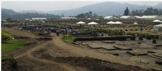
Subestación Nueva Esperanza
