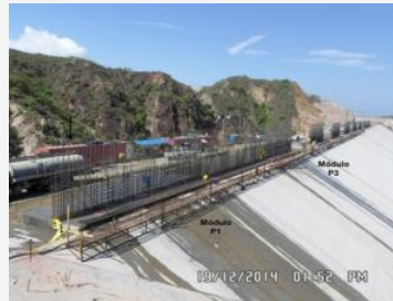
Presas – Acero de refuerzo Muro Parapeto
