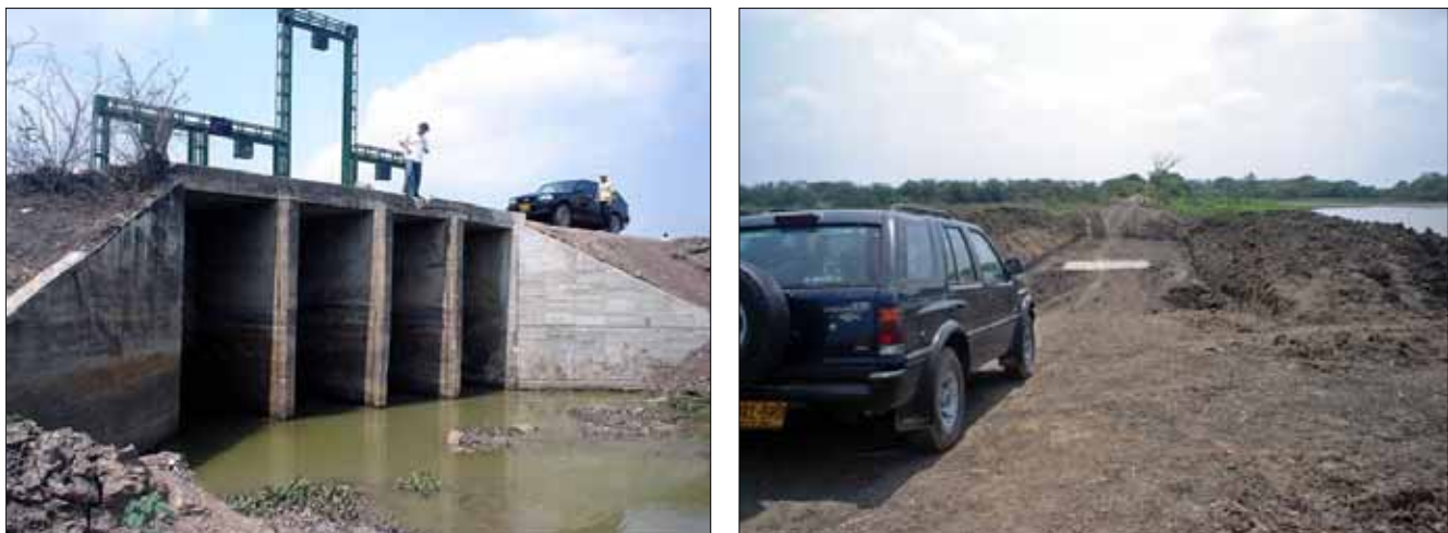
Figura 43: Compuerta y estructura en construcción en la ciénaga El Paraíso. Fuente: CI, 2007
