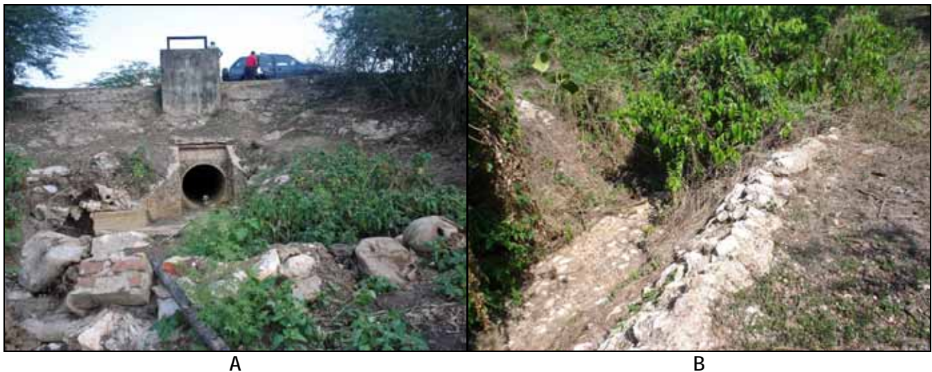
Figura 26: Estructuras para el canal interceptor de los arroyos. A) Alcantarilla de \varnothing = 0,90 metros bajo el terraplén carreteable interceptor. B) Canal aguas abajo de la alcantarillado que conduce el agua al Distrito de Riego de Santa Lucía. Fuente: CI, 2007.
