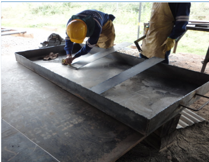
Fotografía izquierda: adecuacion dique portatil para almacenamiento de sustancias quimicas. Fotografía derecha: acopio temporal residuos solidos ATB.
