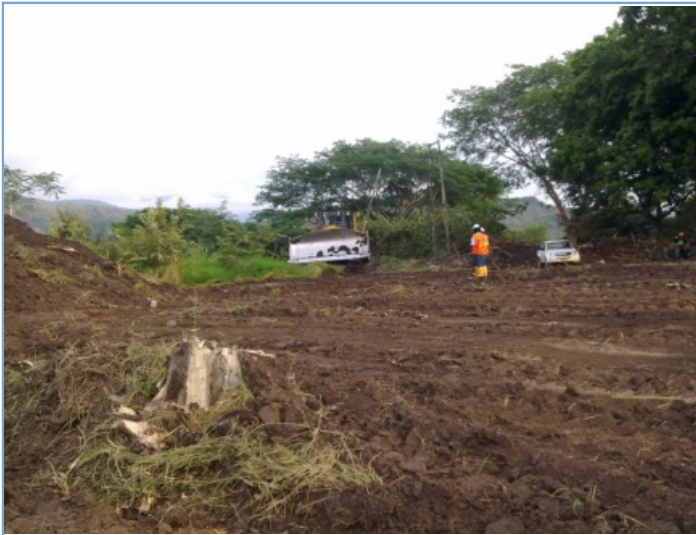
Fotografía: Retiro de la cobertura vegetal de la zona de explotación 14 A
