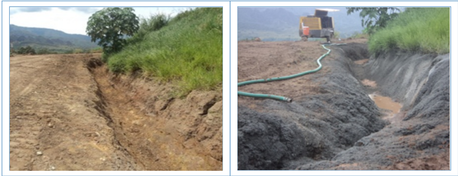
Fotografía izquierda: Elaboración de cunetas para manejo de aguas lluvias en el ZODME 18. Fotografía derecha: Revestimiento en concreto lanzado de cunetas para manejo de aguas lluvias en ZODME 18, esto garantiza que no haya arrastre de sedimentos por las escorrentías.
