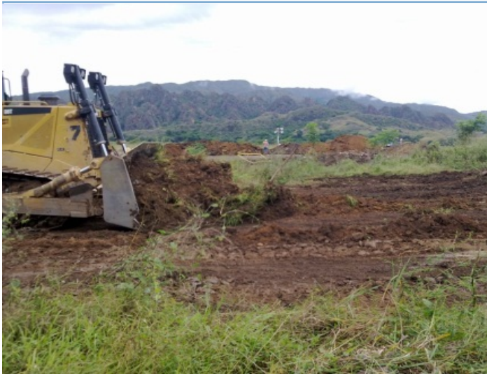
Fotografía: Retiro de la cobertura vegetal de la zona de explotación 14 A
