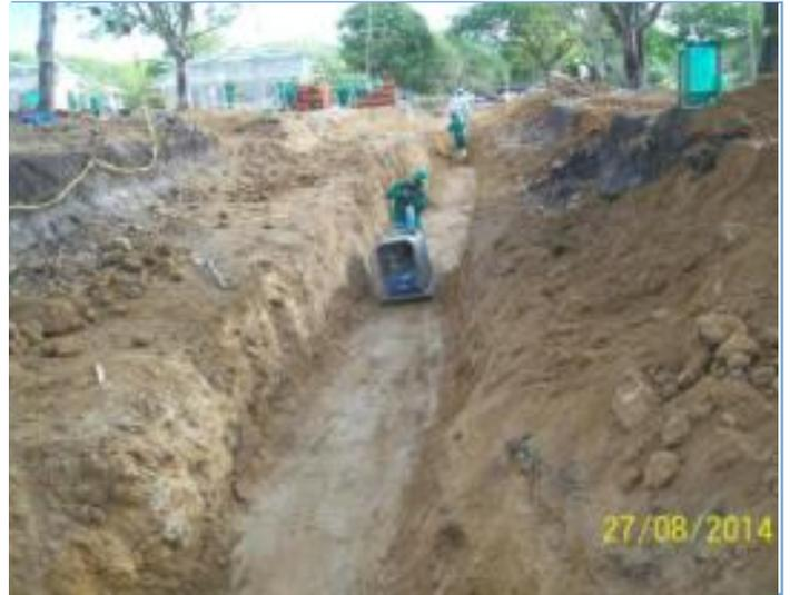
Foto 1. Instalacion tuberia, alcantarillado pluvial.
