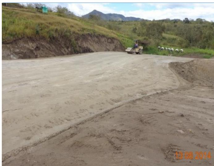
Foto 1. Línea de aducción - Pozo 8A, Instalación geotextil y relleno tipo A.
