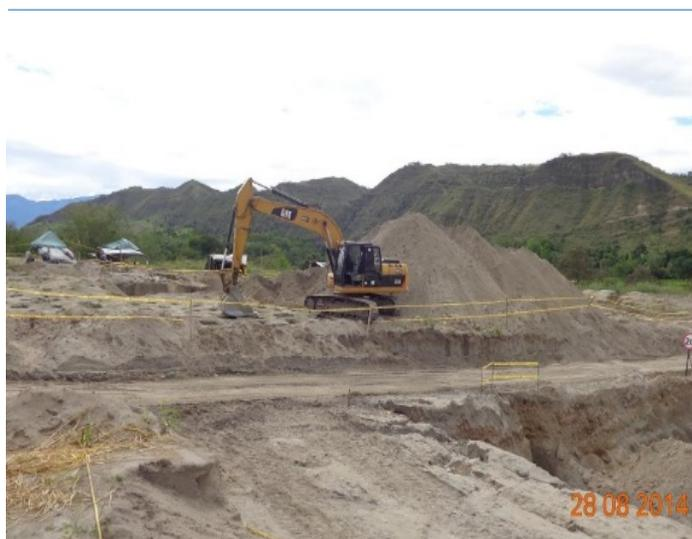
Foto 3. Laguna Facultativa, Excavación zanja tubería de drenaje.
