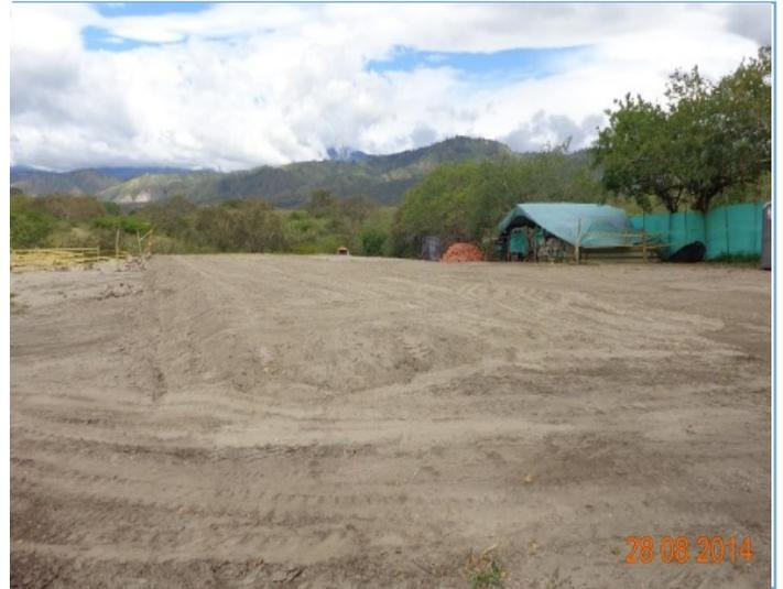
Foto 5. Berma protección ronda embalse K0+560, Conformación capa de relleno tipo A.
