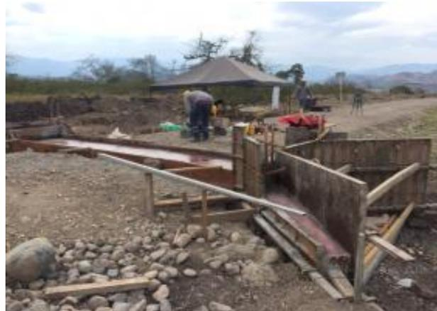
Foto 1. Reservorio, estructura canal de desagüe, armado de acero de refuerzo y encofrado de muros laterales; Se realiza hormigonado en concreto de 21 Mpa para segundo módulo. Foto 2. Eje de vía No 6. Alcantarilla de 24" abscisa K1+503, se realizó encofrado y hormigonado F'c: 21Mpa, para las estructuras de muros y aletas de entrada y salida.
