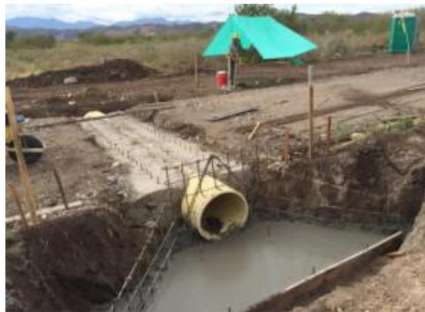
Foto 3. Parcela 23, proceso constructivo del anclaje en concreto de 21 Mpa para los hidrantes. Foto 4. Eje de Vía No. 6. Alcantarilla de 24" abscisa K1+235, Vaciado de concreto en 21 MPa para construcción de placas de fondo en estructuras de entrada y salida.
