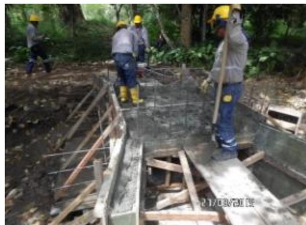
Foto 3. Parcela 11, construcción de enrocado en la estructura de entrega ubicada en la abscisa K0+275 del canal de riego intrapredial. Foto 4. Canal de riego N° 2, Vaciado de concreto de 28 Mpa de muros, placa superior y aletas para construcción de sifón ubicado en la abscisa K0+930.
