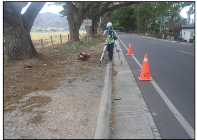
Foto 3. Conduccion, realización de la poligonal entre Parcelación y Bocatoma. Foto 4. Conduccion, replanteo Línea de Conduccion.
