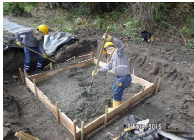
Foto 1. Parcela 07, solado de limpieza para construcción de la estructura de derivación y control simple EDC - S ubicada sobre el canal existente con las siguientes coordenadas: N 739013 y E 816239. Foto 2. Canal de riego N° 2, excavación y solado de limpieza para construcción de la caja para toma predial TP 12 ubicada en la abscisa K1+572.
