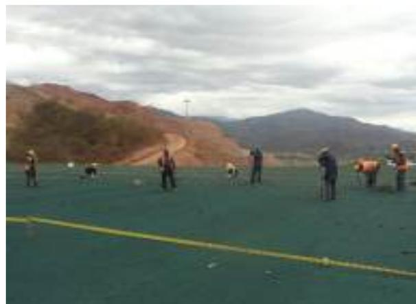
Fotografías 1 y 2. Avances proceso de revegetalización del espaldón aguas abajo del dique auxiliar, suelo orgánico proveniente del banco de suelos del zodme 18.
