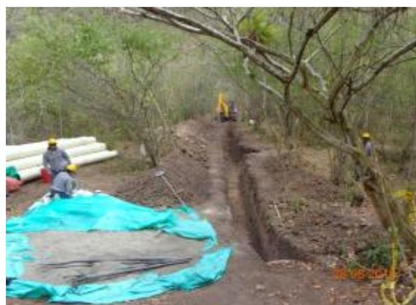
Foto 1. Aduccion, se continua con la construcción de gaviones a la salida de la Bocatoma, en el tramo en que la tubería de aducción se ubica en zona inundable. Foto 2. Conduccion, Se avanza con la excavación mecánica para la instalación de tubería de 14" entre las abscisas K1+170 a la K1+280.
