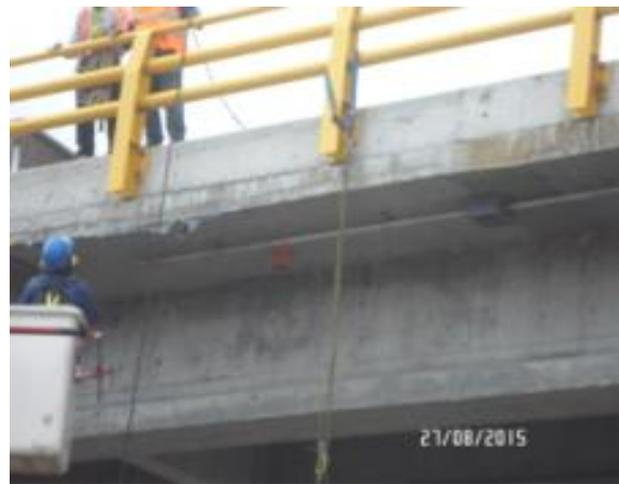
Foto 3. Instalación de ductería para cables de energía.
