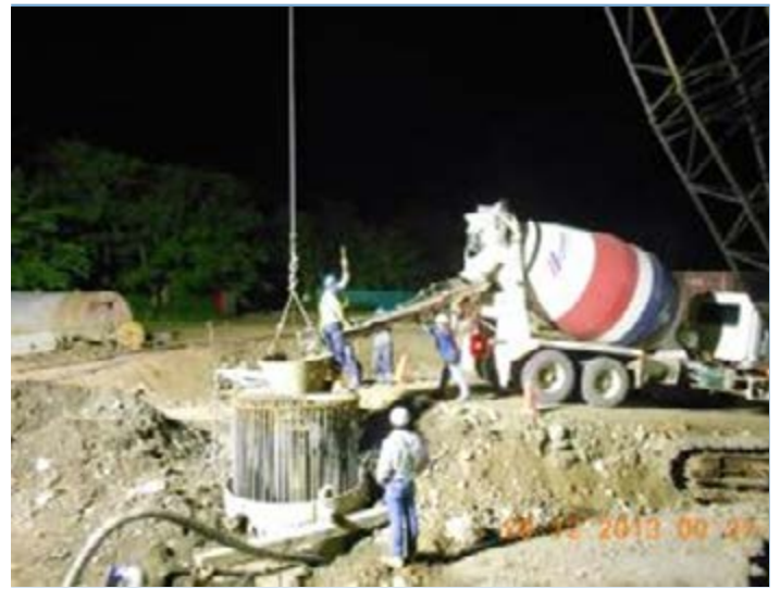
Foto 5. Tramo III, Roceria, repique y tala. Foto 6. Viaducto Balseadero, fundición del pilote 24 eje 6.
