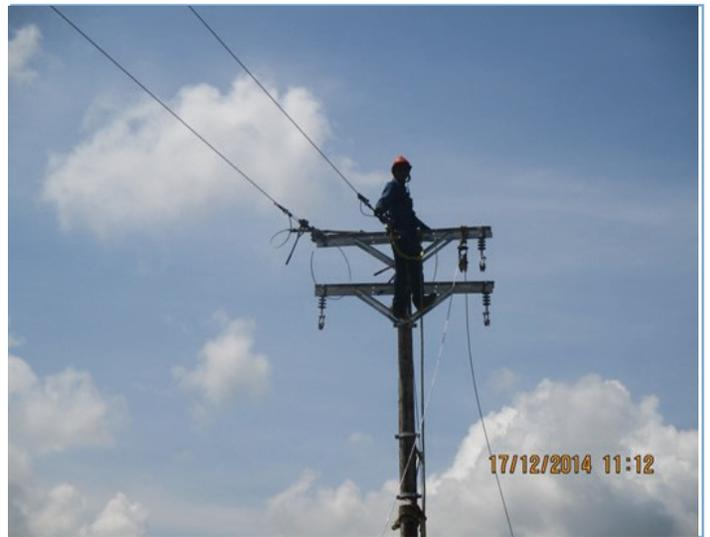
Foto 3. Tramo III Sector B, vestida de Estructura e Instalación de Templetes E-19. Foto 4. La Cañada, tendido de conductor N°2 ACSR
