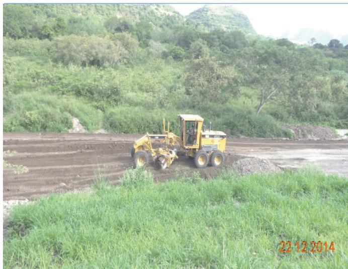
Foto 5. Laguna de maduración, trabajos de arqueología. Foto 6. Berma protección ronda embalse K0+400, se extendió material de descapote con el objetivo de avanzar con la Empradización.
