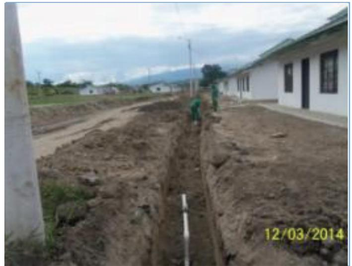
Foto 3. Construcción pozos, alcantarillado pluvial. Foto 4. Instalacion red de acueducto.
