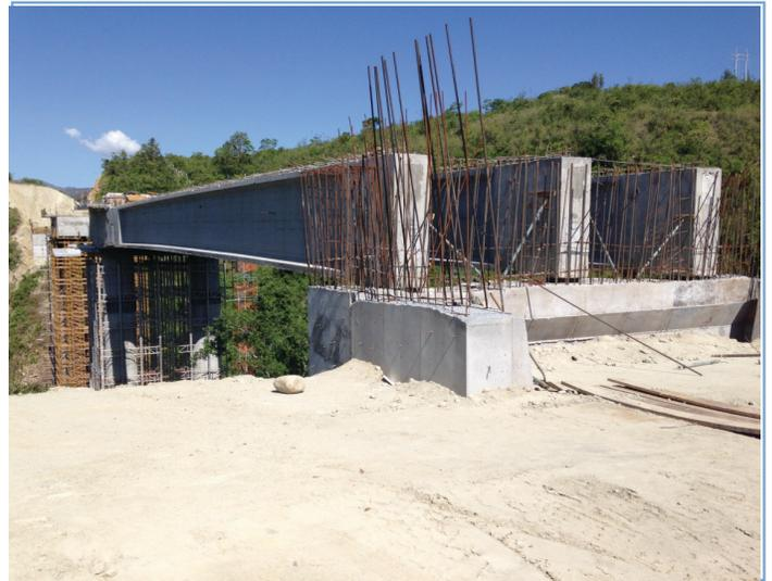
Foto 1. Tramo I - Puente Barrialosa, dovelas e instalación Biomanto. Foto 2. Tramo II - Puente Voltezuela, izaje de vigas postensadas.
