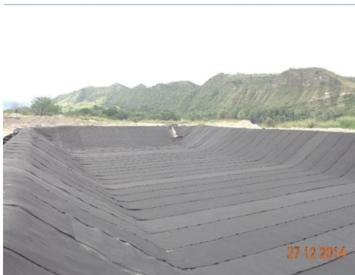
Foto 1. Laguna facultativa, conformación talud. Foto 2. Laguna facultativa, instalación Geodren Planar (50m X2m).
