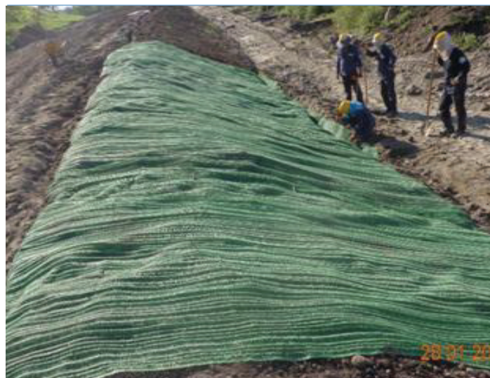
Foto 1. Carrera 6 entre calle 4 y 3, Pavimento en piedra pegada. Foto 2. Berma perimetral, Instalación manto Terratrac.
