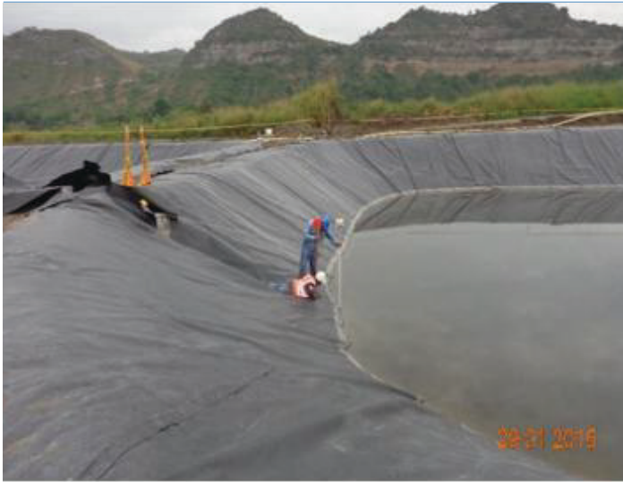
Foto 5. Laguna de anaerobia, prueba de estanqueidad. Foto 6. Canal de descarga, Instalación de parrilla de acero para cuneta triangular.
