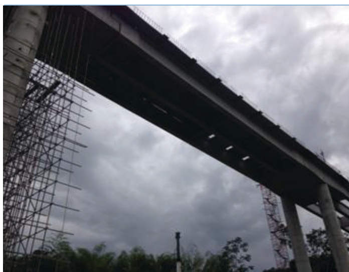
Foto 3. Tramo II - Puente Zajón Seco, losa principal ejes 4 al 5. Foto 4. Tramo II - Puente Voltezuela, izaje de prelosas ejes 2 al 3.
