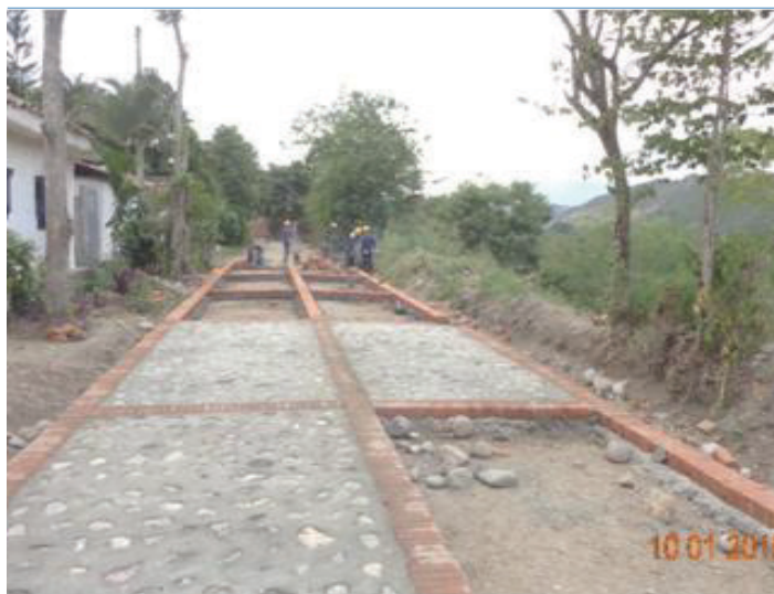
Foto 1. Carrera 6 entre calle 4 y 3, Pavimento en piedra pegada. Foto 2. Berma perimetral, Instalación manto Terratrac.
