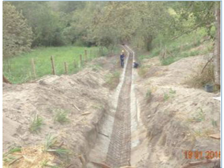
Foto 5. Laguna de anaerobia, prueba de estanqueidad. Foto 6. Canal de descarga, Instalación de parrilla de acero para cuneta triangular.
