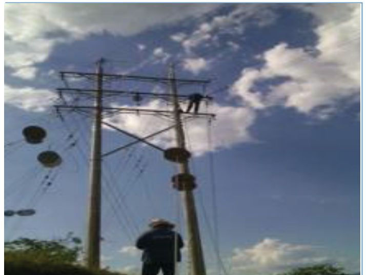
Foto 3. Tramo III Sector B, Tendido de Conductor desde E-12 a E-13. Foto 4. Tramo III Sector B, Tendido de Conductor desde E-13 a E-14.
