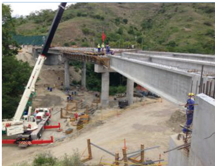
Foto 1. Tramo I - Puente Alonso Sánchez, dovelas ejes 1 y 2. Foto 2. Tramo II - Puente NN3, construcción de losas principales.
