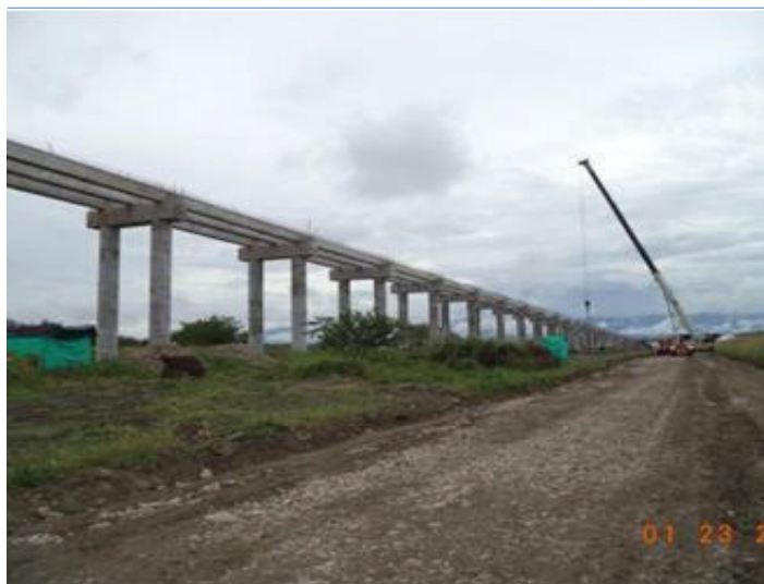
Foto 5. Tramo III - Viaducto Balseadero, Izaje de prelosas ejes 11 al 57. Foto 6. Tramo III - Viaducto Balseadero, Panorámica ejes 1 al 3.
