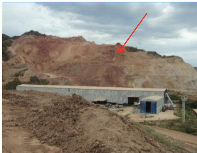
Fotografía 1. Extracción de material del zodme 18 para la conformación del contra-fuerte aguas abajo del dique auxiliar.
