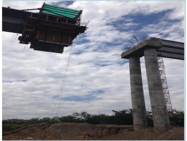
Foto 5, Tramo III - Viaducto Balseadero, Izaje de vigas ejes 11 al 57. Foto 6. Tramo III - Viaducto Balseadero, Construcción de dovelas ejes 4 al 8.
