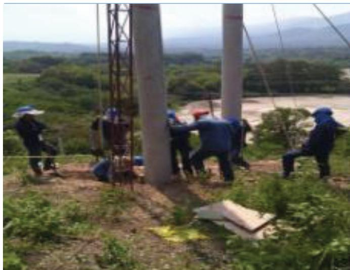
Foto 1. Tramo I, Instalación de estructuras RH 232 para estructura E-02. Foto 2. Tramo II, Izada e hincada de 2 postes de 16 mts. para estructura E-15.
