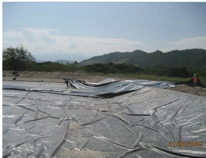
Foto 1. Berma perimetral, Instalación manto Terratrac. Foto 2. Laguna de maduración, Instalación de geomembrana HDPE 40Mils.
