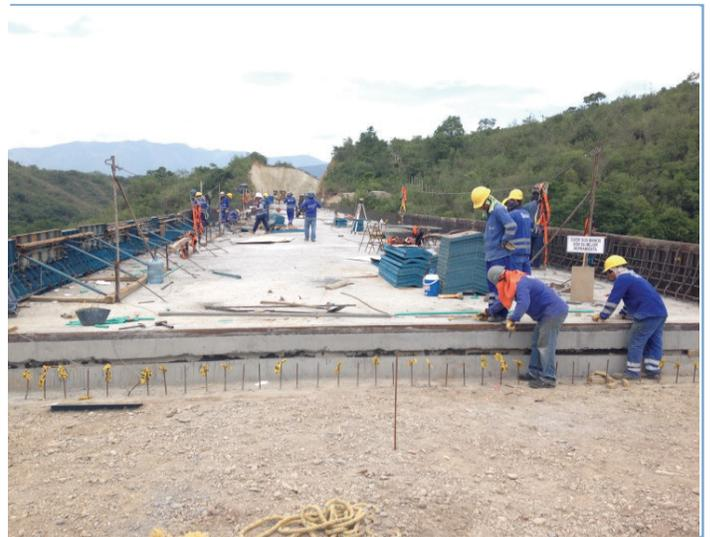
Foto 3. Tramo II -Vía sustitutiva, Pavimentación y cunetas. Foto 4. Tramo II - Puente Voltezuela, Losas de aproximación y New Jersey.
