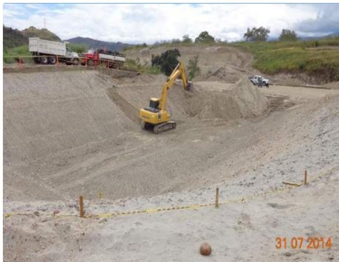
Foto 1. Terraplen, compactación de capas. Foto 2. Laguna anaerobia, excavación material común.
