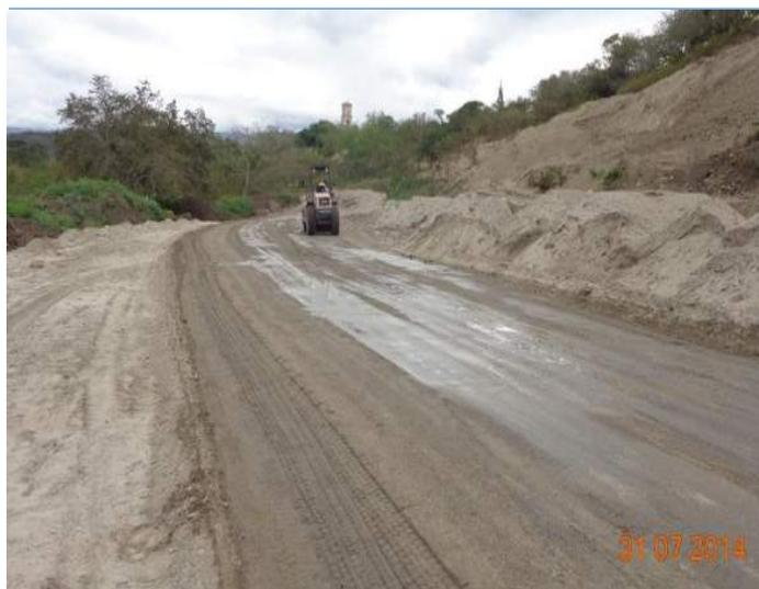
Foto 3. Laguna facultativa, excavación material común. Foto 4. Protección de la ronda, compactación de capas.
