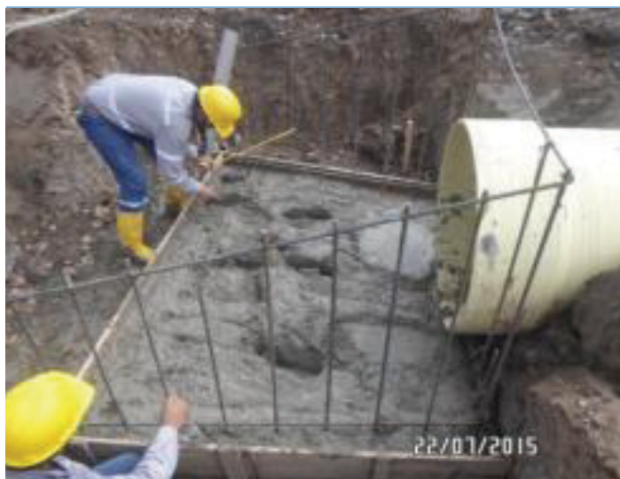
Foto 3. Canal de drenaje N° 4, instalación de acero y vaciado de placa de fondo del costado izquierdo de la alcantarilla de acceso predial, ubicada en la abscisa K0+593. Foto 4. Canal de riego N° 3, relleno con material seleccionado de la excavación para realce del canal de riego entre las abscisas K0+190 al K0+347.
