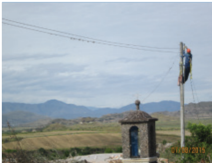
Foto 1. Vereda Veracruz, desmantelamiento de línea de baja tensión.
