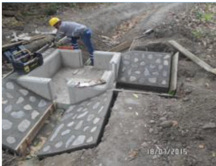
Foto 1. Parcela 1, construcción de enrocado en el encole y descole de la estructura de control y derivación simple de la abscisa K0+390. Foto 2. Canal de riego N° 1, Construcción de enrocado sobre talud del costado izquierdo y derecho entre las abscisas K0+145 al K0+155.
