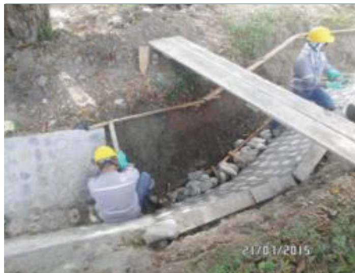
Foto 1. Parcela 1, construcción de enrocado en el encole y descole de la estructura de control y derivación simple de la abscisa K0+390. Foto 2. Canal de riego N° 1, Construcción de enrocado sobre talud del costado izquierdo y derecho entre las abscisas K0+145 al K0+155.
