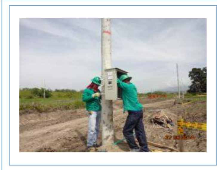
Foto 3: Instalación de tableros de distribución eléctrica. Foto 4: Excavación del alcantarillado sanitario.
