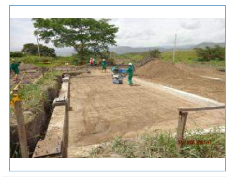
Foto 1: Relleno de cimentación escuela. Foto 2: Relleno alcantarillados y pozos, de la vía eje principal
