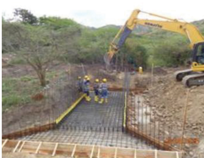
Foto 1. Desarenador, fundición del último tramo de los muros de la estructura. Foto 2. Vía eje N°1 Box-Culvert, fundición de la placa de piso.
