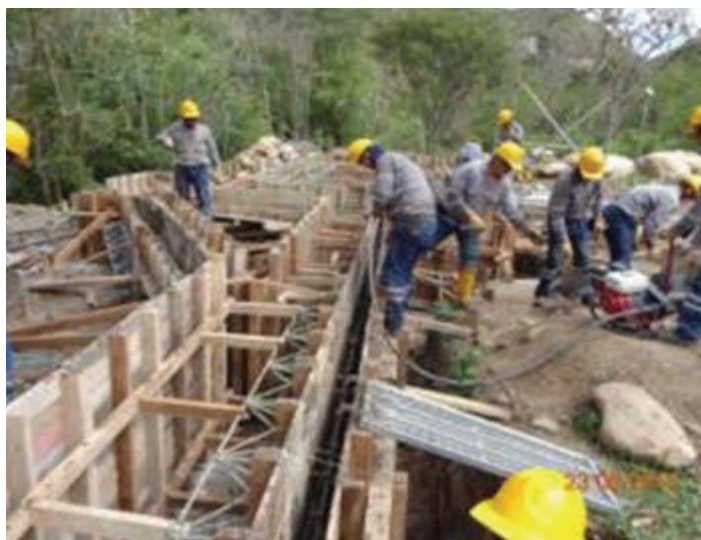
Foto 1. Desarenador, fundición del último tramo de los muros de la estructura. Foto 2. Vía eje N°1 Box-Culvert, fundición de la placa de piso.
