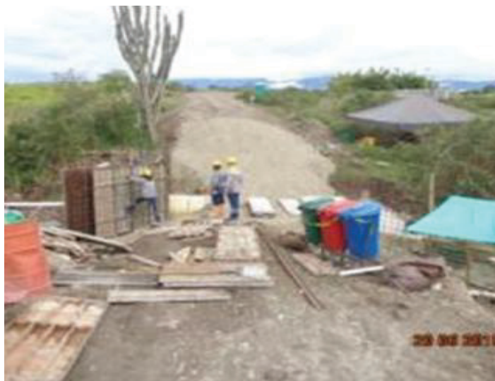
Foto 1. Eje de via N° 5, construcción de alcantarilla de 36". Foto 2. Ramal parte alta N°6, instalación de tubería PVC biaxial de 6".
