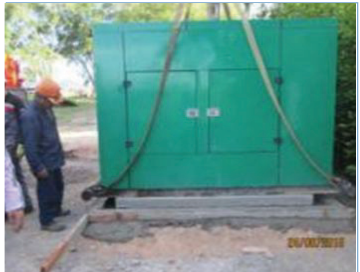
Foto 3. Vereda Veracruz, plantas que reemplazarán los transformadores aún en operación.
