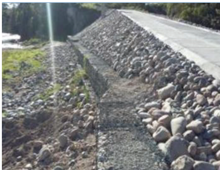
Foto 3. Muelle La Cañada, terminación de muro en gaviones.
