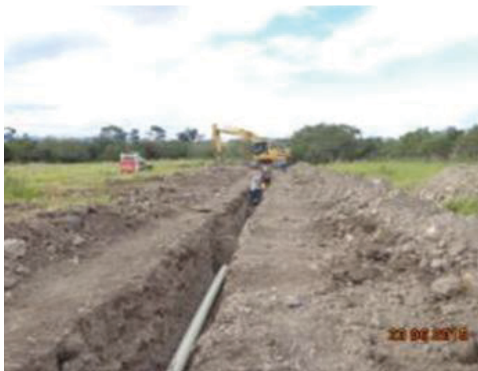
Foto 1. Eje de via N° 5, construcción de alcantarilla de 36". Foto 2. Ramal parte alta N°6, instalación de tubería PVC biaxial de 6".
