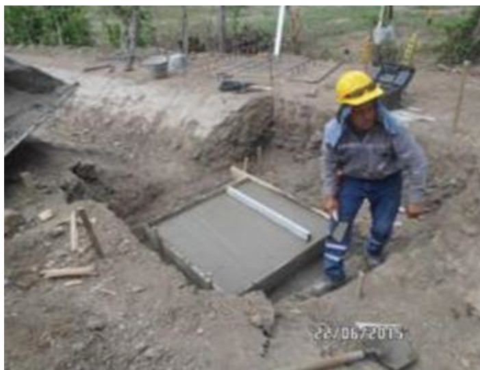
Foto 1. Parcela 7, construcción de la estructura de derivación y control doble EDC - D. Foto 2. Eje de vida N° 2, instalación de la última capa de afirmado (10 cm) y cereo.
