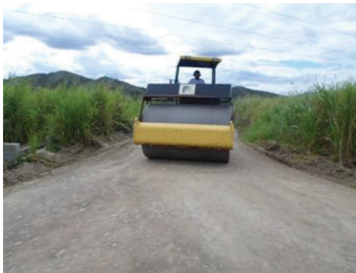
Foto 1. Vías intraprediales, trabajos de compactación. Foto 2. Accesos Intraprediales, construcción de estructuras de paso.
