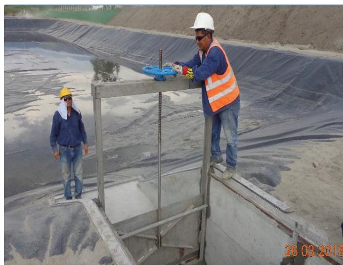
Foto 3. Lechos de secado, llenado de los lechos de secado con material filtrante (arena). Foto 4. Estructura de salida, instalación de compuerta plana deslizante.
