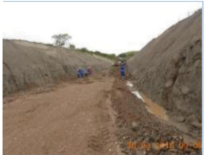
Foto 7. Tramo IV - Puente La Cañada, puente terminado. Foto 8. Tramo IV - La Cañada, sub-base y construcción de cunetas.
