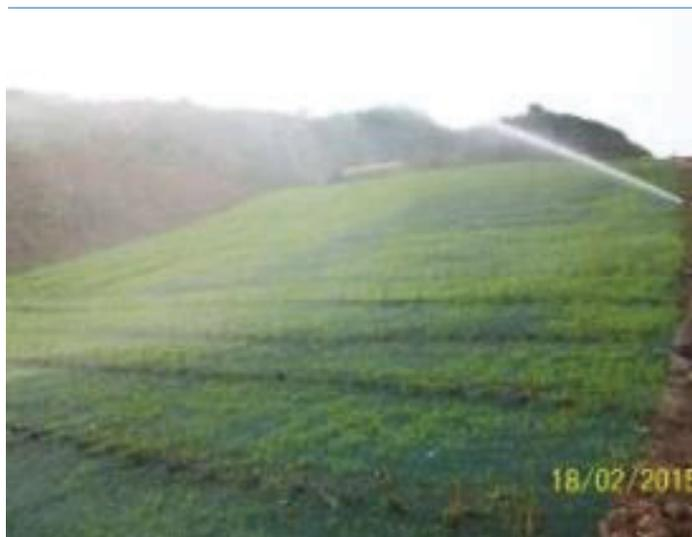
Fotografía 3. Utilización de material banco de suelos en el proceso de revegetalización del dique auxiliar.
