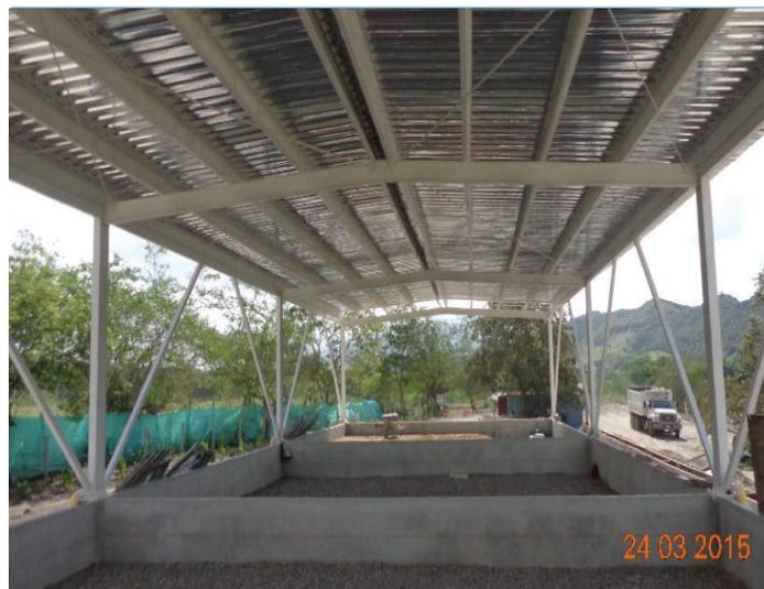
Foto 1. Cabezal de entrega - Lechos de secado, instalación de piedra pegada. Foto 2. Lechos de secado, Instalación de cubierta (teja arquitectónica).
