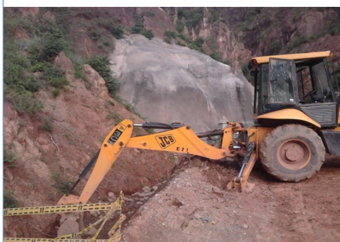
Fotografías: Adecuación del canal para el manejo de las aguas a la galería
