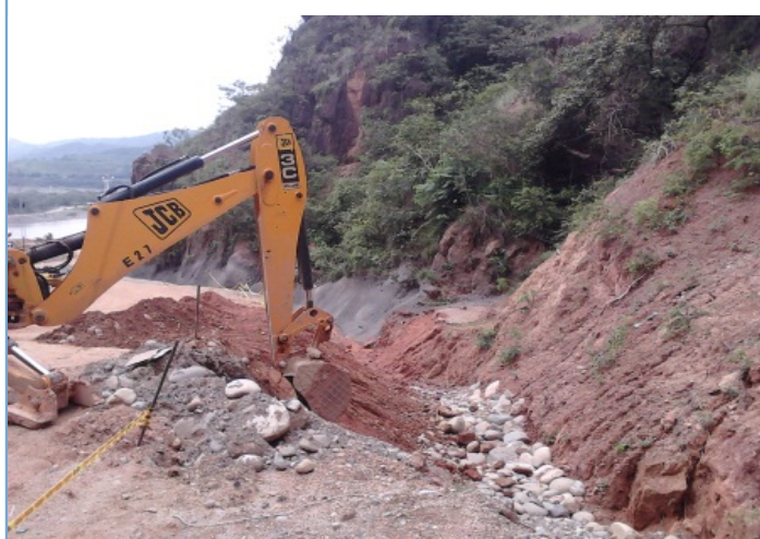
Fotografías: Adecuación del canal para el manejo de las aguas a la galería
