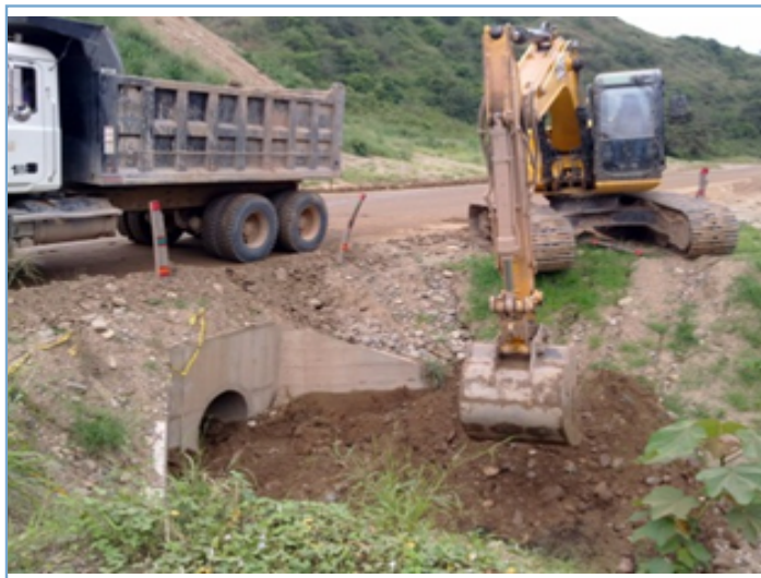
Fotografía izquierda: Limpieza con ayuda mecánica en alcarillas dispuestas para los cruces viales de cuerpos de agua en vía margen izquierda. Fotografía derecha: Vista panorámica de las cunetas perimetrales para manejo de aguas lluvias en deposito 24, posterior a mantenimiento.
