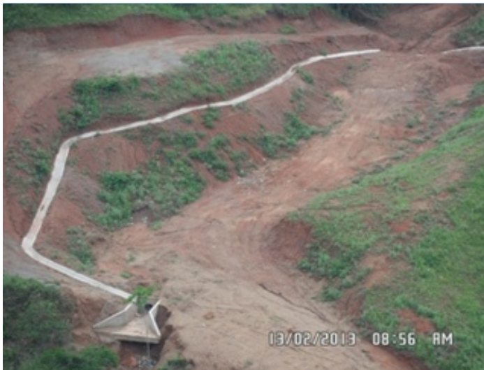
Fotografía izquierda: Limpieza con ayuda mecánica en alcarillas dispuestas para los cruces viales de cuerpos de agua en vía margen izquierda. Fotografía derecha: Vista panorámica de las cunetas perimetrales para manejo de aguas lluvias en deposito 24, posterior a mantenimiento.
