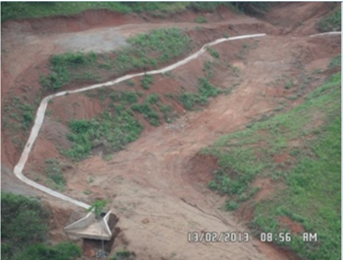
Fotografía izquierda: Limpieza con ayuda mecánica en alcarillas dispuestas para los cruces viales de cuerpos de agua en vía margen izquierda. Fotografía derecha: Vista panorámica de las cunetas perimetrales para manejo de aguas lluvias en deposito 24, posterior a mantenimiento.
