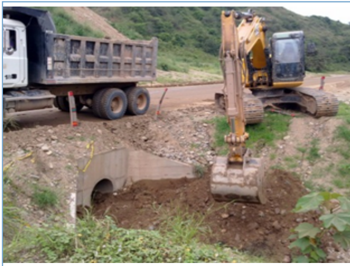
Fotografía izquierda: Limpieza con ayuda mecánica en alcarillas dispuestas para los cruces viales de cuerpos de agua en vía margen izquierda. Fotografía derecha: Vista panorámica de las cunetas perimetrales para manejo de aguas lluvias en deposito 24, posterior a mantenimiento.
