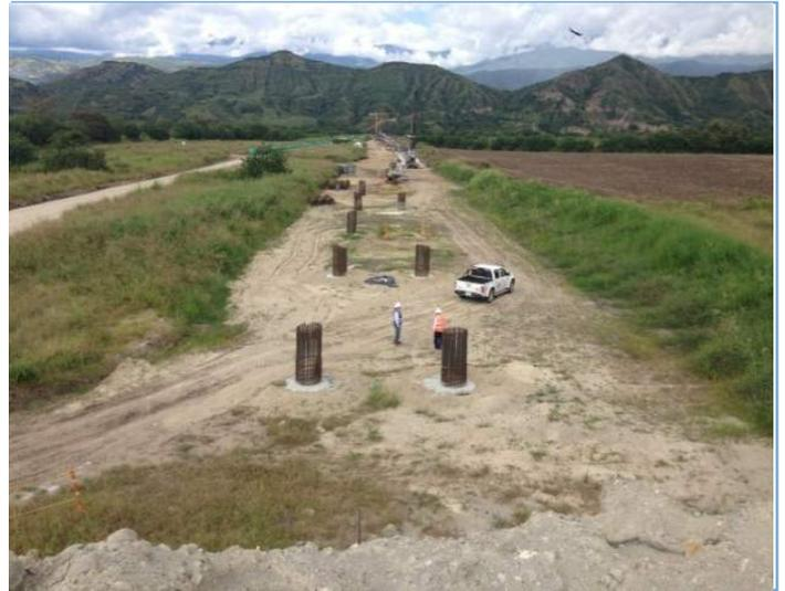
Foto 5. Viaducto Balseadero. Vista general pilotes sector dovelas.
