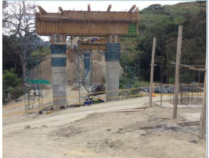
Foto 1. Tramo I, pistas para construcción de vigas postensadas Puente Zajón Seco.
