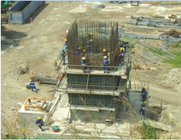
Foto 5. Tramo III, viaducto Balseadero, construcción columna hueca eje 3. Foto 6. Tramo III, Viaducto Balseadero, construcción dovelas eje 8.
