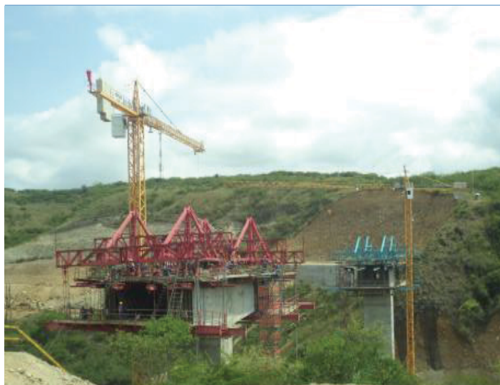
Foto 1. Tramo I, construcción dovelas puente A. Sanchez. Foto 2. Tramo II, construcción de vigas puente NN1.
