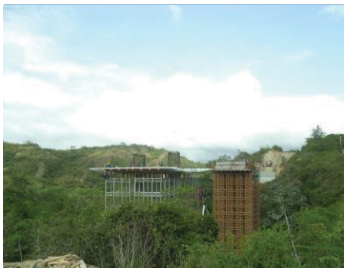
Foto 3. Tramo II, izaje de vigas puente NN3. Foto 4. Tramo II, construcción viga cabezal puente voltezuela.
