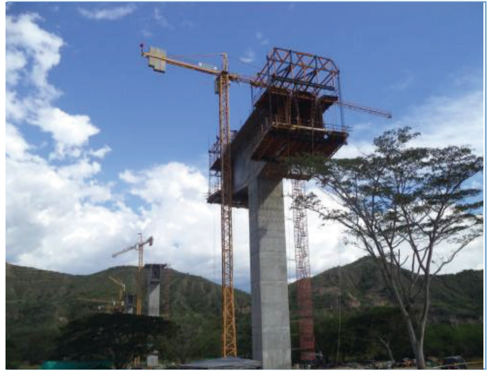
Foto 5. Tramo III, viaducto Balseadero, construcción columna hueca eje 3. Foto 6. Tramo III, Viaducto Balseadero, construcción dovelas eje 8.
