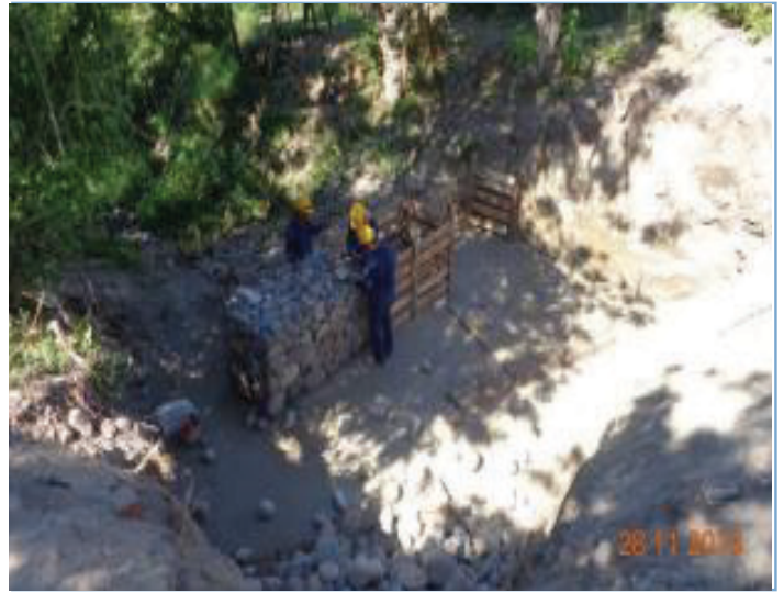
Foto 5. Laguna anaerobia, trabajos de reparación del geodren. Foto 6. Cr 6 con cll 5 (Costado centro de salud), construcción gaviones.
