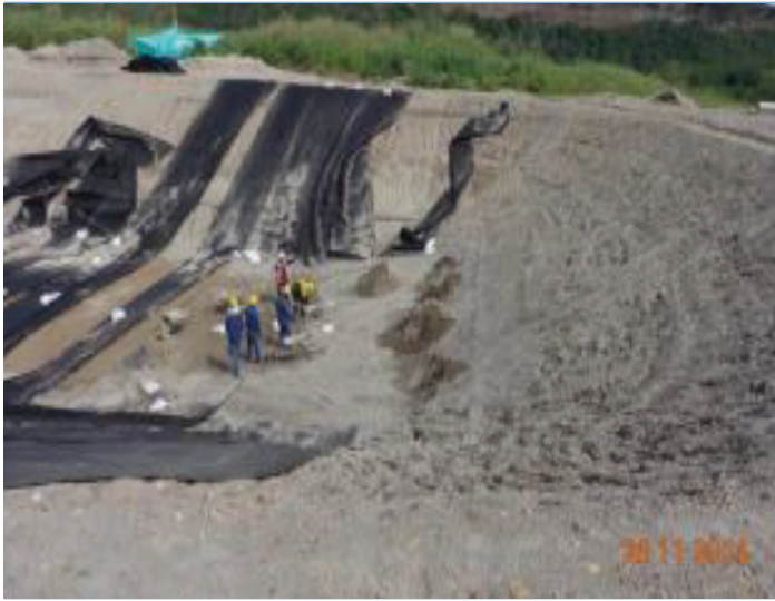
Foto 5. Laguna anaerobia, trabajos de reparación del geodren. Foto 6. Cr 6 con cll 5 (Costado centro de salud), construcción gaviones.
