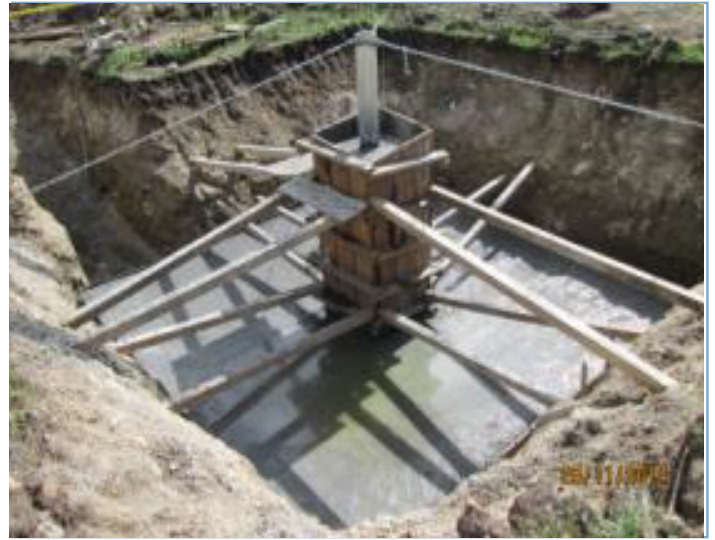
Foto 5. Tramo III Sector B - Torre E-13, Armado de aceros para STUBS 2 y 3. Foto 6. Tramo III Sector B - Torre E-13, Vaciado de concreto zapata 2 y 3.
