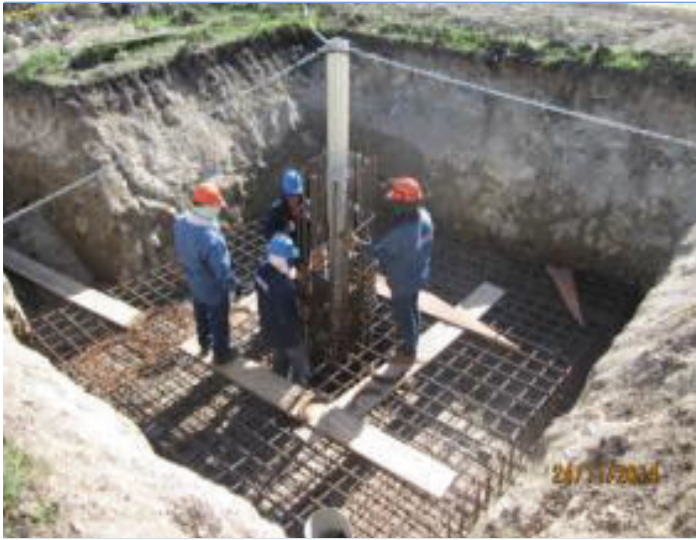
Foto 5. Tramo III Sector B - Torre E-13, Armado de aceros para STUBS 2 y 3. Foto 6. Tramo III Sector B - Torre E-13, Vaciado de concreto zapata 2 y 3.
