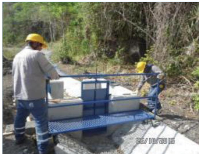
Foto 1. Canal N° 1, vaciado de muros en concreto de 28 Mpa para construcción de estructura de disipación donde finaliza el canal de riego No. 1 en el K1+546 e inicia el canal de riego No. 2. Foto 2. Canal N° 2, instalación de barandas y pasarelas sobre la toma predial TP 12 ubicada en la abscisa K1+450.
