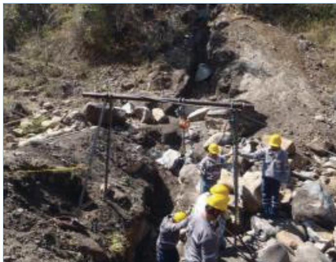
Foto 1. Aduccion, revestimiento de gaviones en concreto de 3000 PSI. Foto 2. Alineamientos conduccion, excavación en roca, perfilado de fondo de la excavación para instalar tubería de conducción, se instala un codo de 14" biaxial de 11,25° en la abscisa K3+170 y se instala tubería biaxial de 14" entre las abscisas K3+171 - K3+182.
