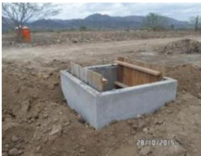
Foto 3. Eje de vía No. 5, abscisa K1+800, se realiza excavación de hallazgos por la comisión arqueológica. Foto 4. Ramal No 3 Red distribución parte alta. Caja valvula de control y ventosa, armado acero de refuerzo y hormigonado de losa de piso y muros en concreto de 28 Mpa.
