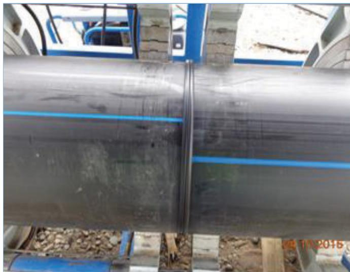
Foto 1. Bocatoma, vaciado concreto muro sedimentador y muro protección margen izquierda. Foto 2. Instalaciones de faena, se realizan trabajos de Termofusión de Tubería PEAD 450 mm.
