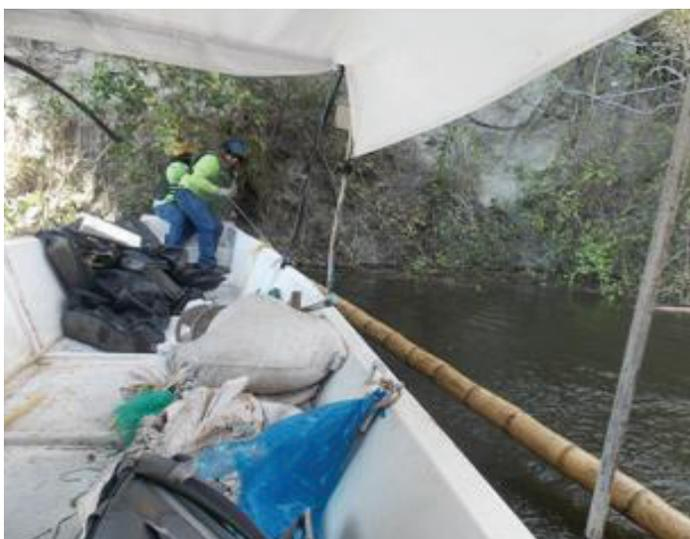
Aislamiento de macrófitas en zonas de ensenadas con barreras de guadua. Instalación de barrera de guadua para el aislamiento y contención de macrófitas.
