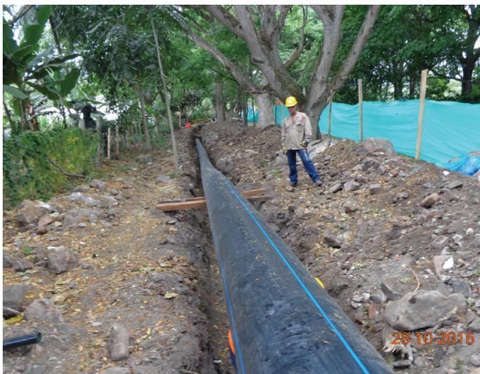
Foto 3. Conducción K0+650 a K0+800, instalación Tubería PEAD 450 mm. Foto 4. Conducción K0+650 a K0+800, instalación Tubería PEAD 450 mm.
