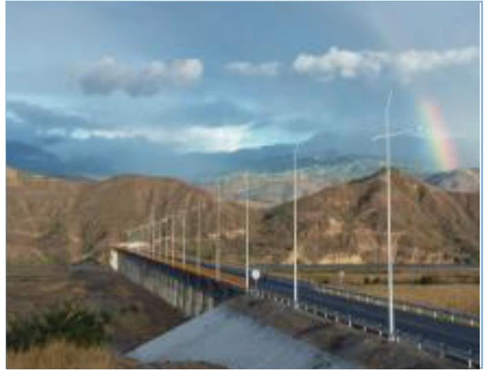
Foto 1. Balseadero, instalación de bajantes acometida transformador de 5 KVA marca siemens y del tablero general. Foto 2. Viaducto Balseadero, postes tipo aguja con su respectiva luminaria.
