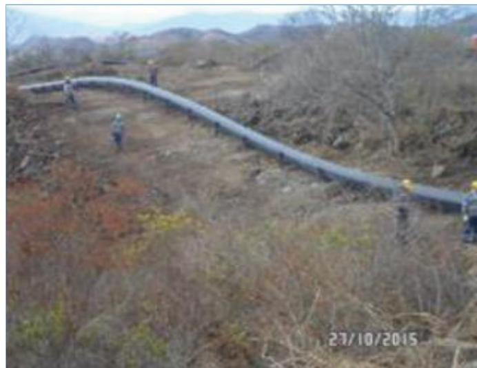
Foto 1. Eje de vía No 7. Alcantarilla de 24" en la abscisa K1+155, se realizó armado de acero de refuerzo y hormigonado de las estructuras de entrada y salida (muros, aletas, losa superior). Foto 2. Perfil No 1 Red distribución parte alta, tramo abscisa K0+856,85 al K1+185, instalación de tubería de polietileno PEAD de 22" apoyada sobre los marcos "H".
