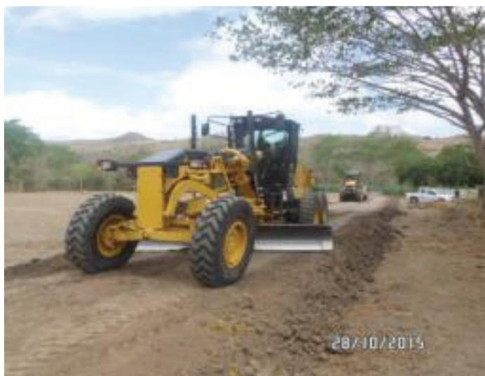
Foto 3. Parcela 12, encofrado de muros para construcción de la estructura de derivación y control doble EDC - D ubicada en la abscisa K0+054 del canal de riego intrapredial No. 1. Foto 4. Parcela 06, relleno con material seleccionado de la excavación para conformación del canal de riego intrapredial entre las abscisas K0+000 al K0+130 y entre el K0+180 al K0+240.
