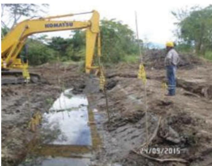
Foto 3. Canal de riego N°2, vaciado de muros en concreto de 28 Mpa para reconstrucción de la toma predial TP 06 ubicada en la abscisa K0+570. Foto 4. Parcela 12, excavación para construcción de alcantarilla doble de 24" ubicada en la abscisa K0+130 del canal de riego intrapredial.
