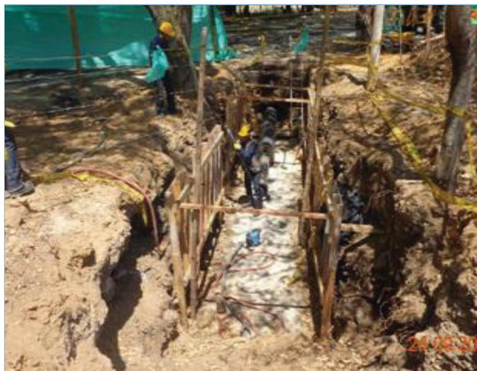
Foto 1. Conducción, hincado de la tubería de acero (sistema Ramming). Foto 2. Parcelas, excavación y entibado para equipo de perforación.
