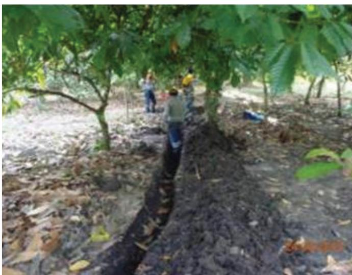
Foto 3. Parcela 3, instaló tubería de 2" y 1" en área sin restricción forestal. Foto 4. Parcela 20, continua la excavación manual para la instalación de tubería de 3" y 21/2".
