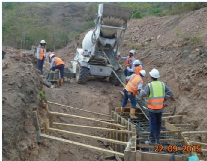
Foto 1. Tramo III: K3 +537, instalación acero de refuerzo para anclaje de concreto de codo vertical. Foto 2. Tramo III: K3+510, vaciado de concreto de 21 Mpa, para anclaje en codo 33 Horizontal.
