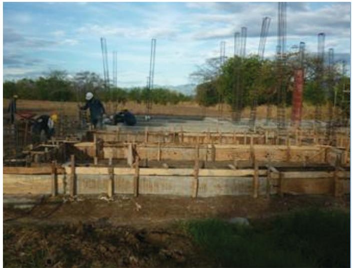
Instalación de formaletas y vaciado de vigas de cimentación de la estación piscícola en la Granja experimental de la USCO (El Juncal, Palermo-Huila).
