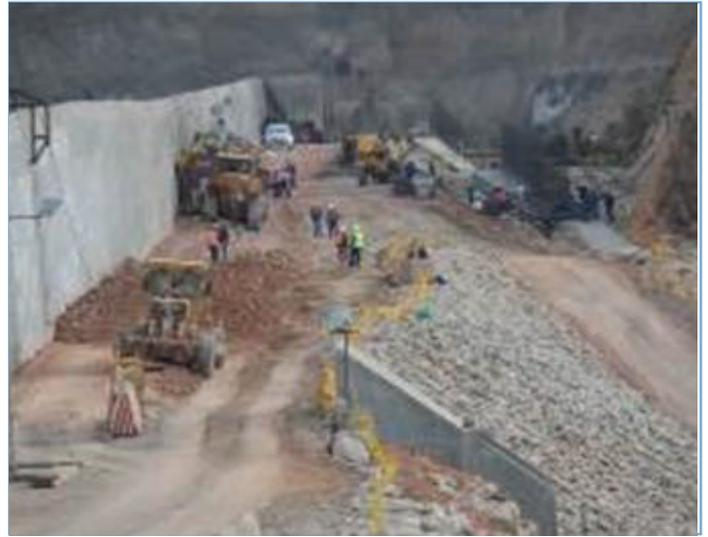
Fotografías 1 y 2. Actividad de conformación del lleno del muro parapeto.
