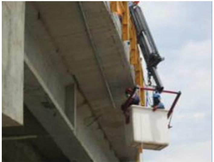
Foto 3. Balseadero, instalación de caja de paso para poste sobre pedestal. Foto 4. Viaducto Balseadero, instalación de ductería con la grúa sobre el viaducto.
