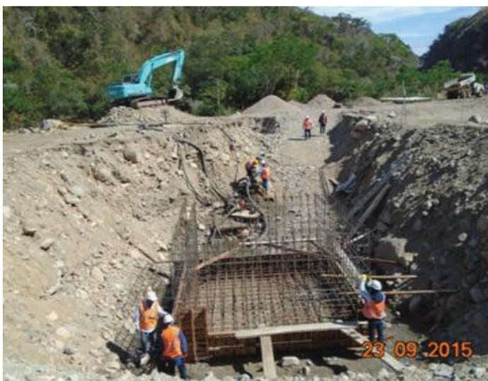
Foto 3. Zona de acopio, suministro de tubería PEAD. Foto 4. Viaducto: k2+220, instalación de acero de refuerzo, para muerto de anclaje.
