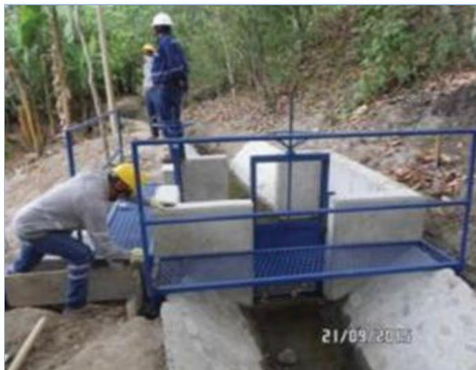
Foto 1. Parcela 11, encofrado y vaciado de muros en concreto de 28 Mpa para construcción de la estructura de derivación y control simple EDC - S ubicada en la abscisa K0+005 del canal de riego intrapredial.
