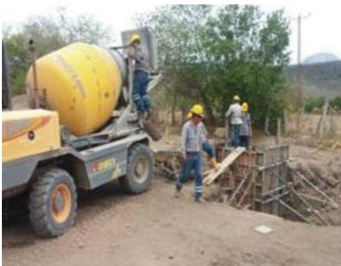
Foto 3. Parcela 54 parte alta, encofrado y hormigonado en concreto de 28Mpa. Cajila toma predial con tapas. Foto 2. Perfil conduccion #2 caja valvula, hormigonado para construcción de muros y tapas de caja de válvula de purga, ubicadas en las abscisas K1+190.
