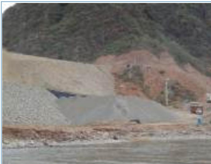
Material acopiado para ser utilizado luego en la conformación de los principales llenos. (Dique auxiliar - Aguas abajo de la presa).
