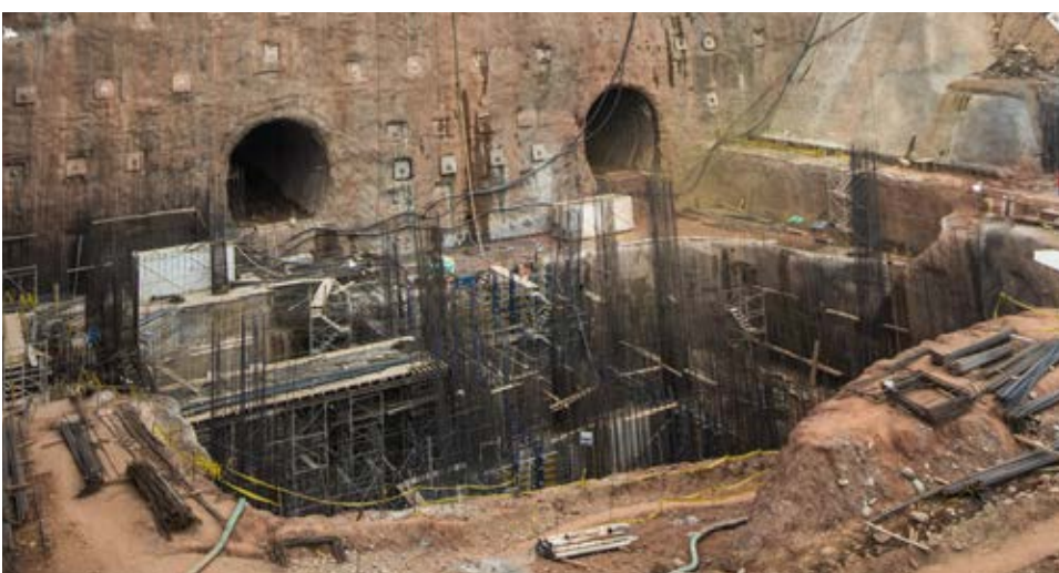
Casa de Máquinas
