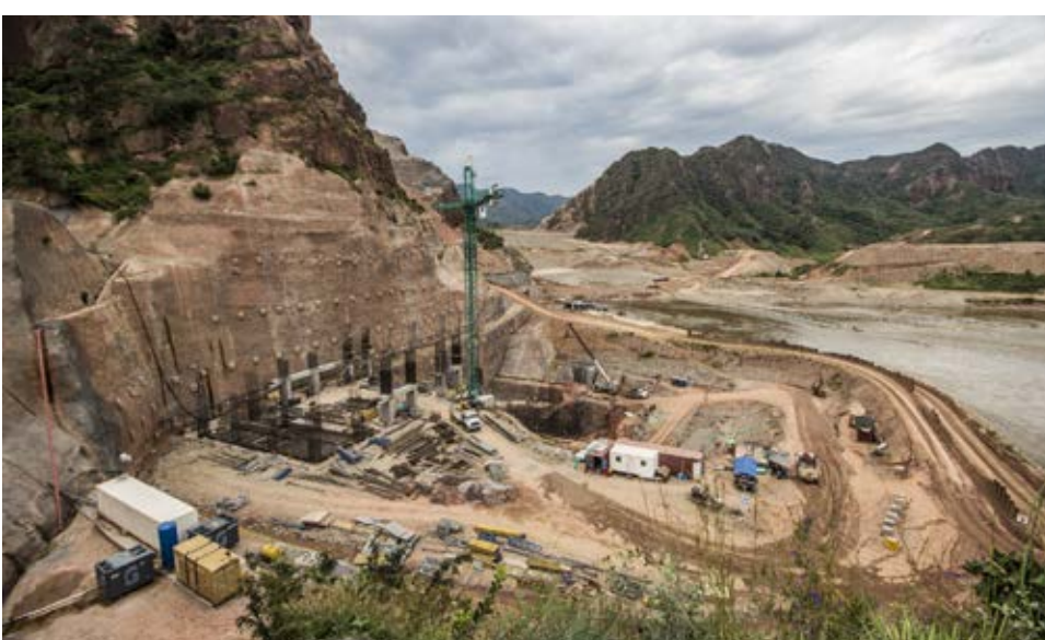
Casa de Máquinas
