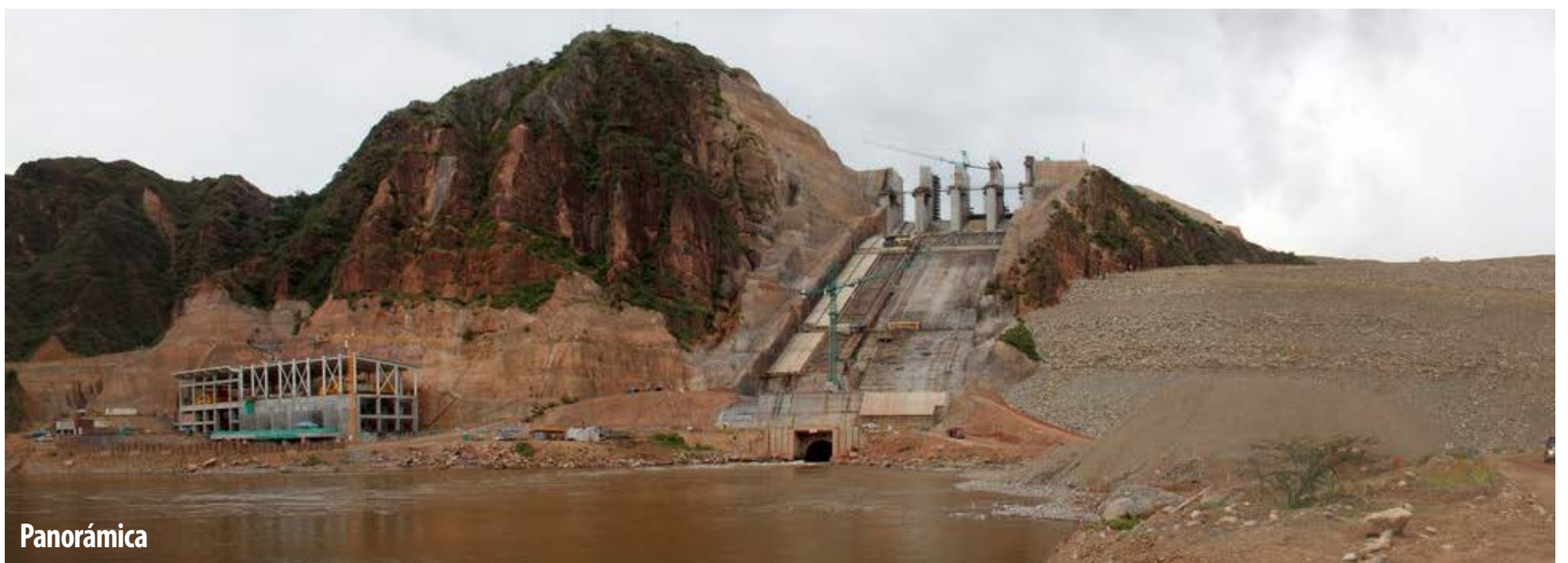
Casa de Máquinas
