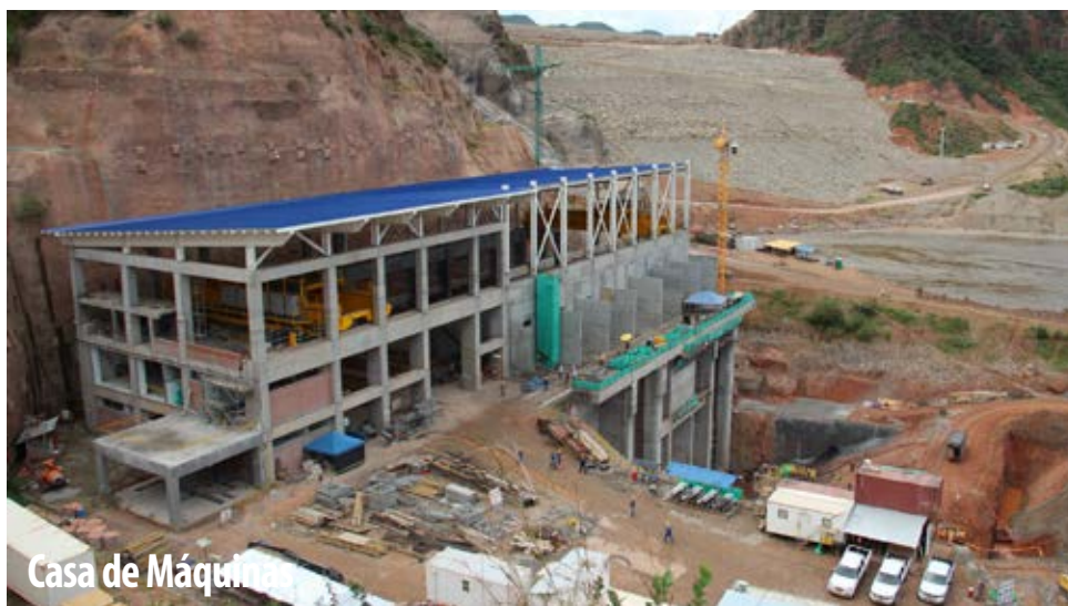
Casa de Máquinas
