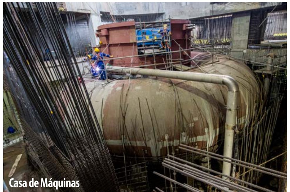
Casa de Máquinas
