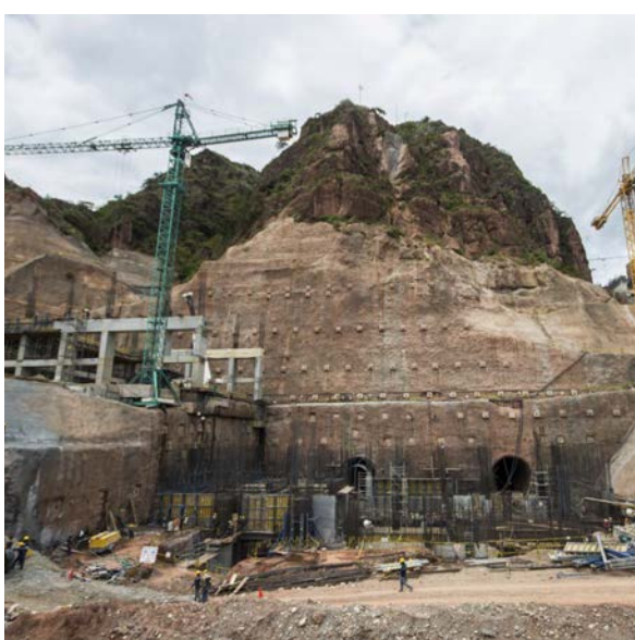
Casa de Máquinas
