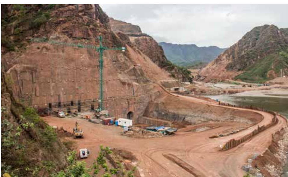
Casa de Máquinas
