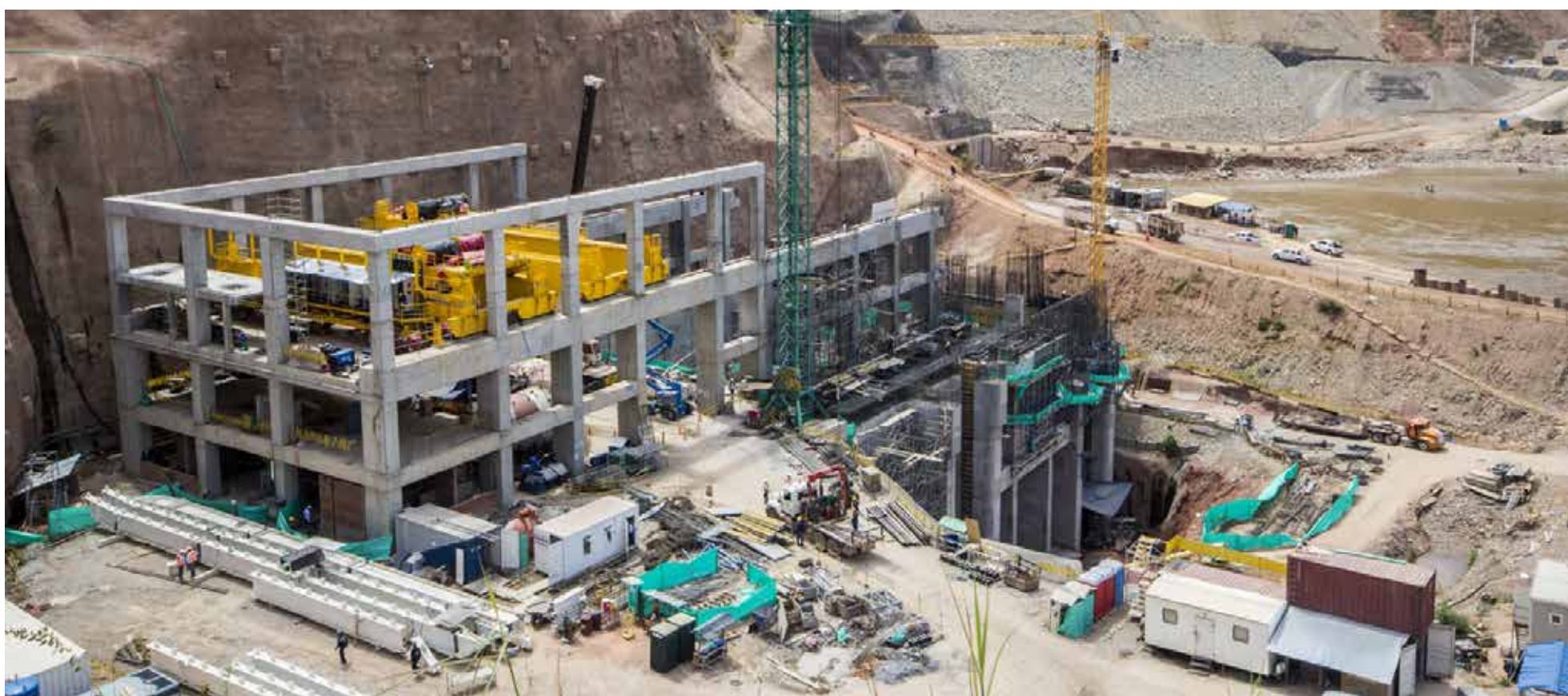
Casa de Máquinas
