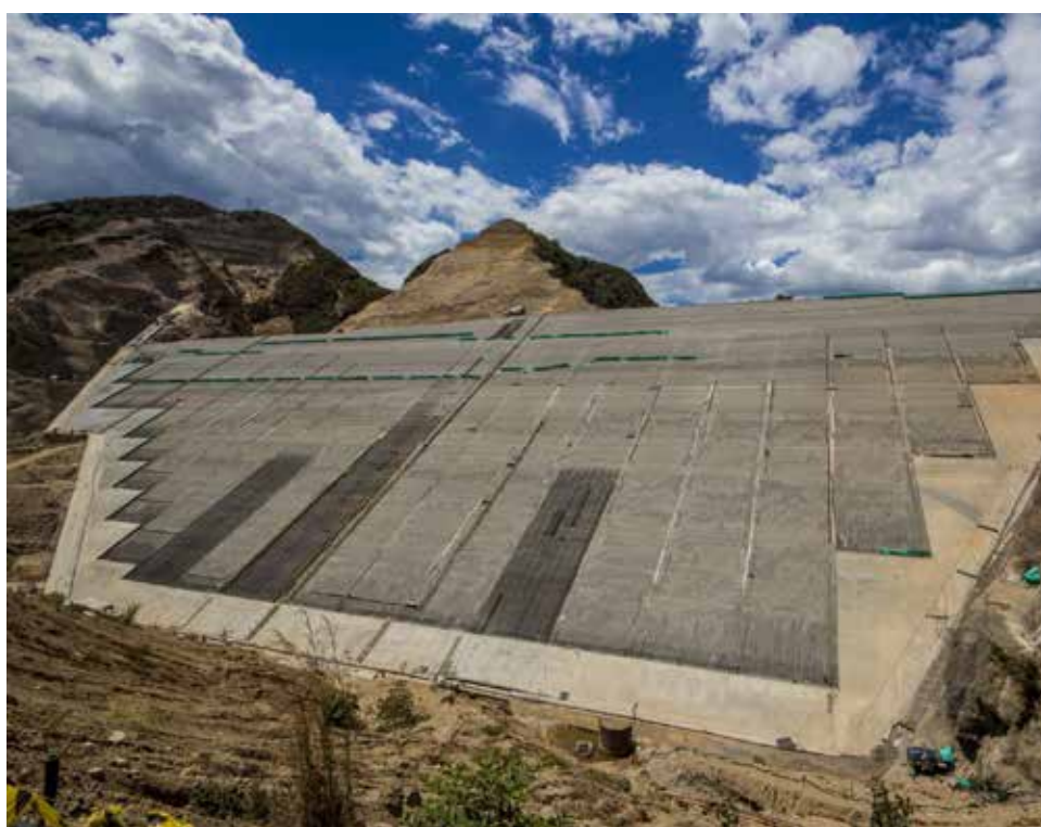
Rellenos de la Presa
