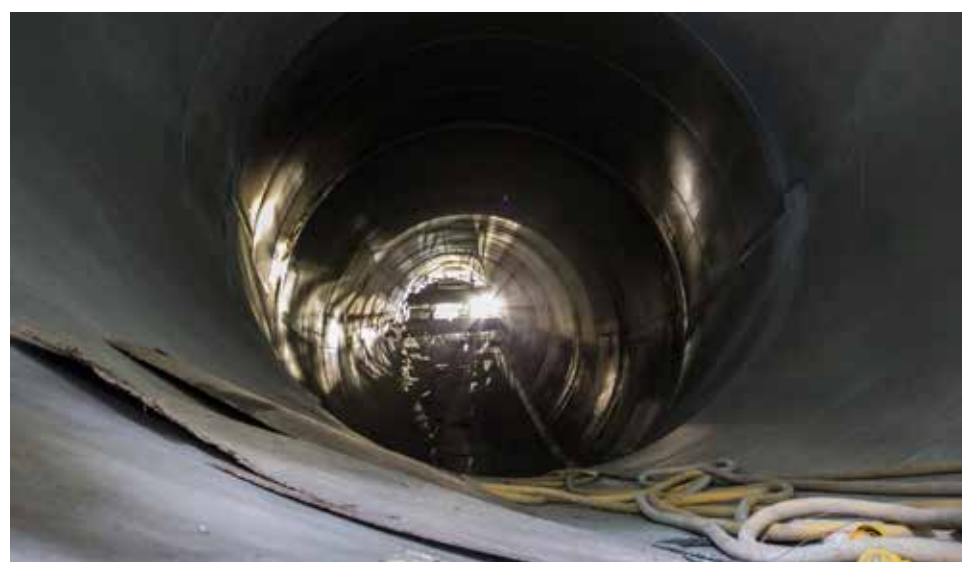
Túneles de Carga y Pozos de Compuertas
