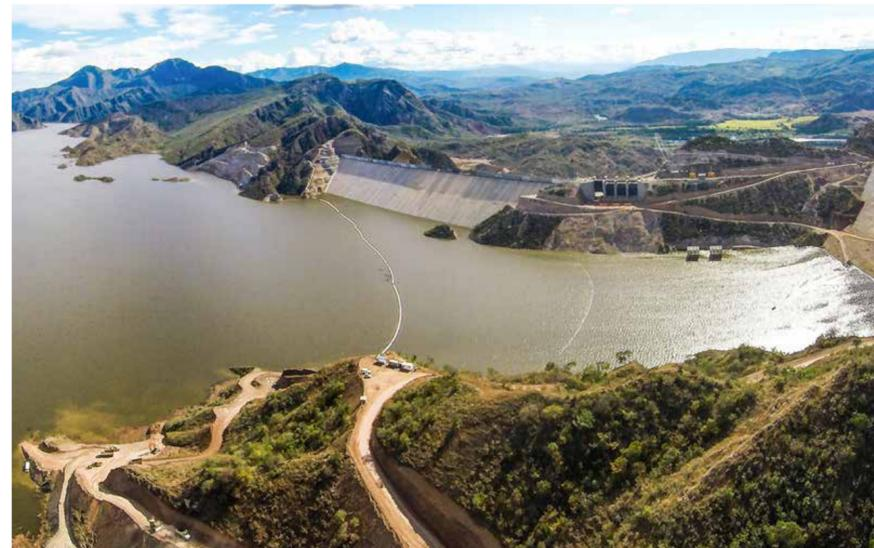
La estructura de descarga de fondo cuenta con una compuerta que se mantendrá abierta mientras el proceso de llenado, permitiendo así el paso del caudal ecológico que exige la Licencia Ambiental del proyecto. Una vez las turbinas de la casa de máquinas comiencen a generar energía, esta compuerta se cerrará.
