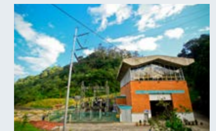
Central menor Charquito - San Antonio, ubicada en el Distrito de Manejo Integrado Cerro Majui-Salto del Tequendama.
