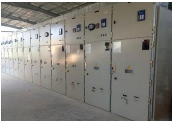
Con el objetivo de atender las necesidades de demanda de energía para clientes industriales los municipios de Funza y Cota, se realizó la instalación de un nuevo transformador de 63 MVA a un nivel de tensión 115/34,5 kV y la instalación de una bahía de 115 kV para la conexión del transformador. Adicionalmente, se construyó una nueva casa de control e instalación de nuevas celdas de 36 kV para la conexión de los circuitos de alimentación de los clientes industriales.
